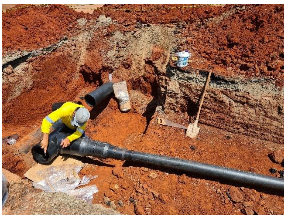
Figura TEC 4 – Coletor de esgoto no São Sebastião (Fotos da obra fornecidos pelo DAE).
