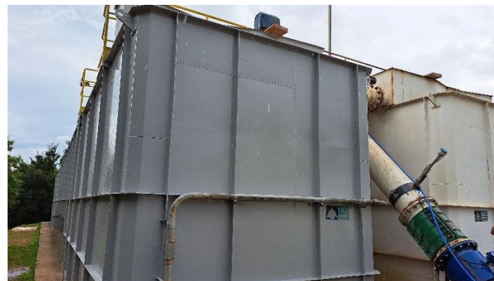
Foto 2 – Vista externa da ETA Compacta: à esquerda já reformado e em operação; à direita irá entrar em reforma.
