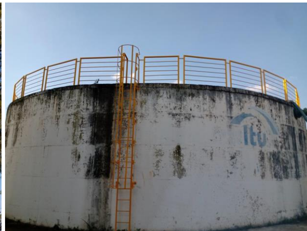
Foto 1 e 2 – Guarda-corpos nos Reservatórios Elevado do Pirapitingui e no Apoiado do Pirapitingui.
