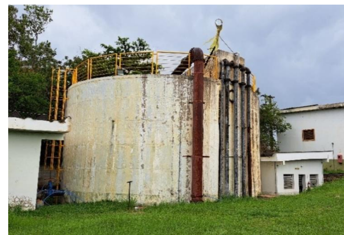
Foto 3 – Guarda-corpos no Reservatório Apoiado Itaim.
