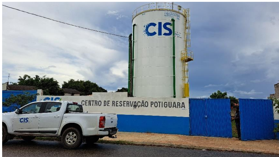
Foto 1 – Novo Reservatório Apoiado do Parque Residencial Potiguara.
