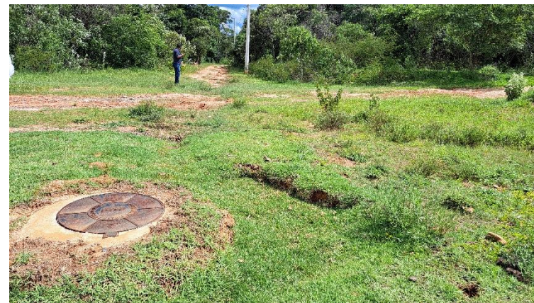
Foto 2 – Sequencia dos PVs ao longo do trecho no novo emissário de efluente da ETE Pirajibu até o Ribeirão Pirajibu.
