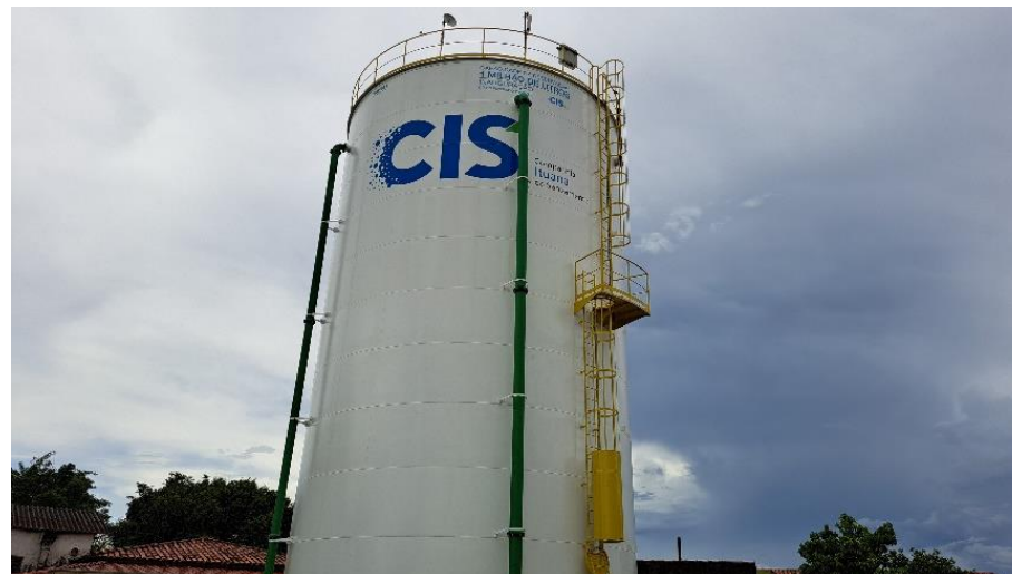
Foto 2 – Novo Reservatório Apoiado do Parque Residencial Potiguara.
