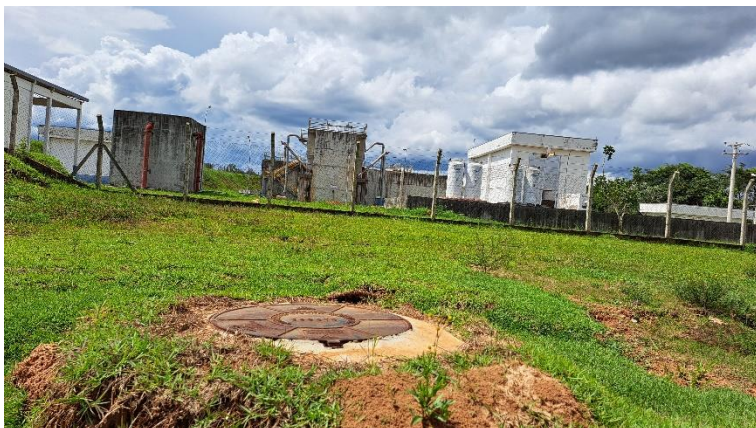
Foto 1 – PV do novo emissário de efluente da ETE Pirajibu até o Ribeirão Pirajibu.
