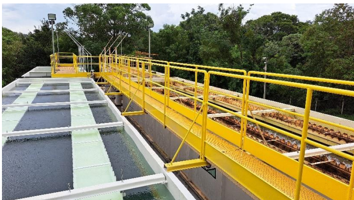
Foto 1 – Vista superior da ETA Compacta: à esquerda já reformado e em operação; à direita irá entrar em reforma.
