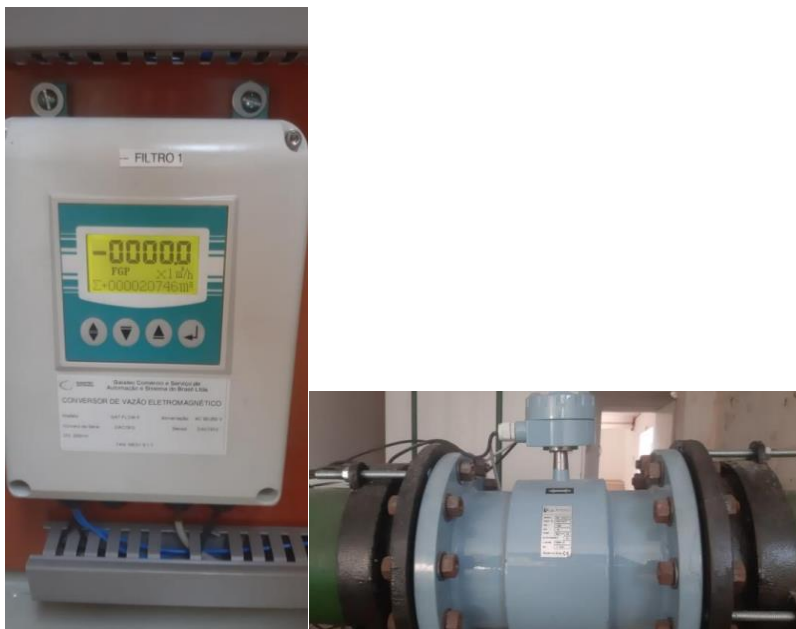
Fotos 1 e 2 - Um dos macromedidores instalados na ETA I – Rancho Grande Fonte: Gaiatec Systems – Relatório Medição 1.
