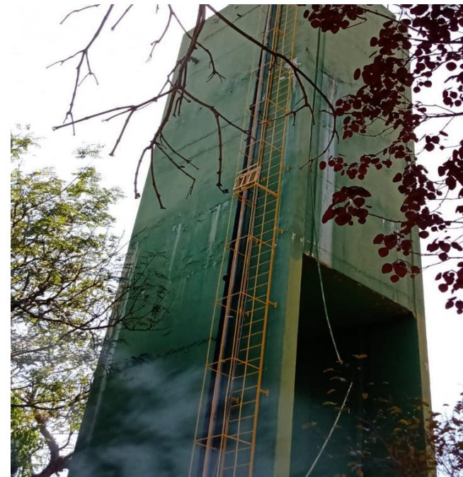
Foto 5 – Guarda-corpos no Reservatório Elevado City Castelo.
