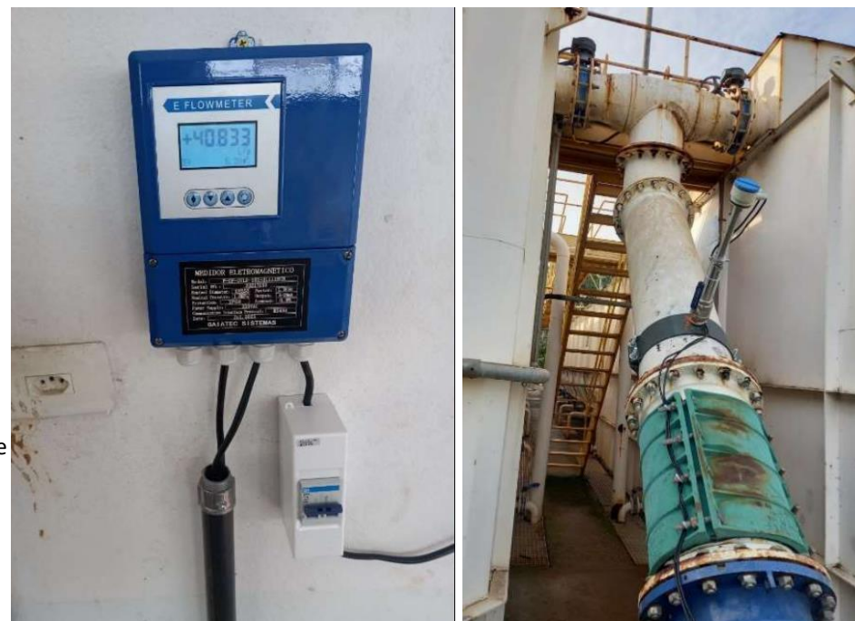
Fotos 3 e 4 - Um dos macromedidores instalados na ETA Compacta VII Fonte: Gaiatec Systems – Relatório Medição 10.
