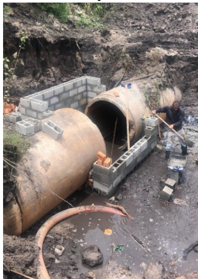
Construção de PV
