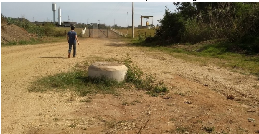
PV do novo trecho do interceptor na chegada à ETE
