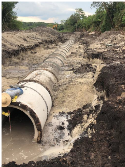
Assentamento de tubos
