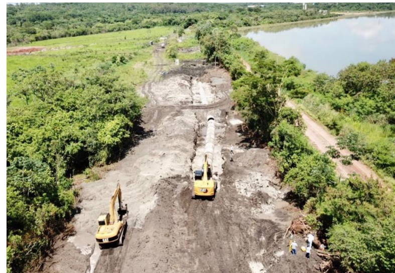
Vista do assentamento de tubos
