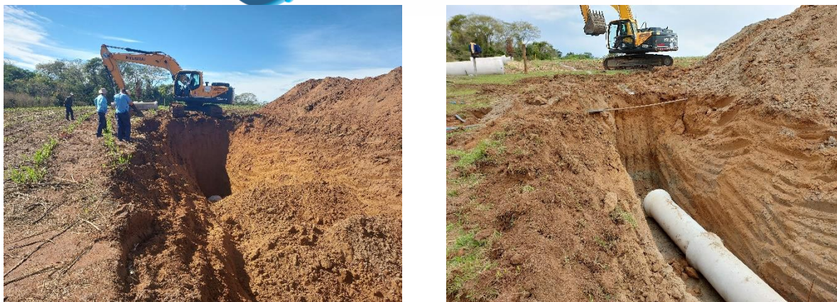
Figura TEC 1: Interceptor de esgoto zona leste – 1º etapa (Fonte: SAEP)
