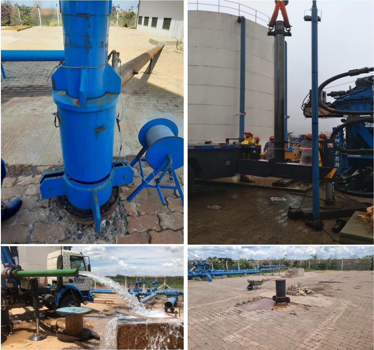
**Figura TEC 3 –** Perfuração de Poço Tubular Profundo na Chácara Flora II (Fotos da obra fornecidos pelo DAAE).
