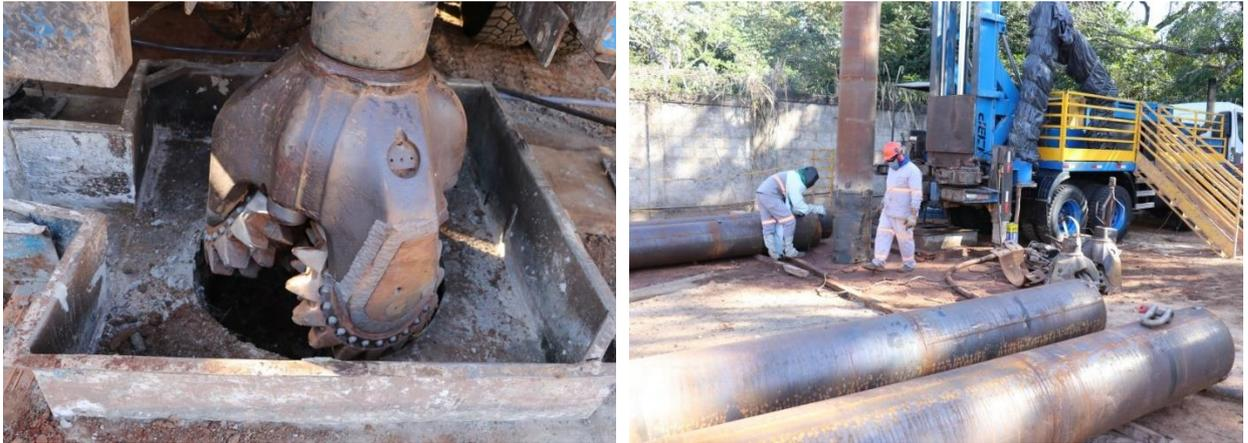
**Figura TEC 4 –** Perfuração de Poço Tubular Profundo Santa Lúcia II (Fotos da obra fornecidos pelo DAAE).
