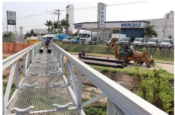
Figura TEC 3 – Remanejamento de redes de água da Rodovia João Cereser – Etapa 1 9 (Fonte: DAE Jundiá)
