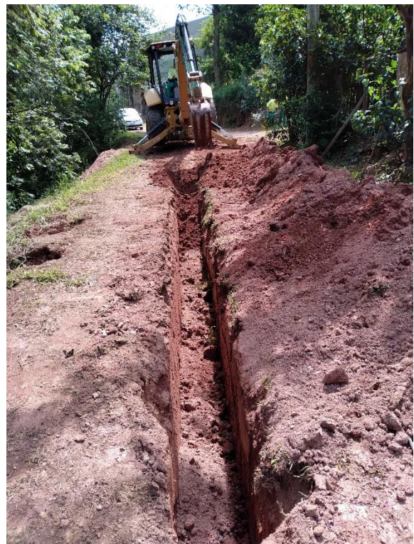
Figura TEC 6 – Extensão de interceptadores e rede coletoras Rua Bonilha (Fonte: DAE Jundiaí)
