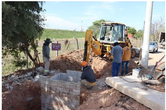
Figura TEC 10 – Extensão de interceptadores e rede coletoras Varjão
