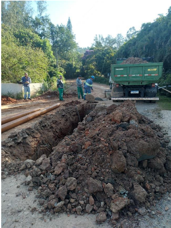
Figura TEC 7 – Extensão de interceptadores e rede coletoras Rua dos Favas (Fonte: DAE Jundiá)
