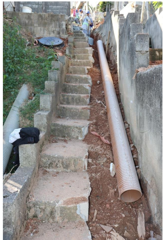
Figura TEC 12 – Extensão de interceptador Casa Branca (Fonte: DAE Jundiaí)
