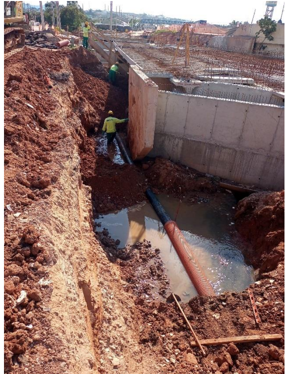
Figura TEC 5 – Extensão de interceptadores e rede coletoras Marginal do Vencedor (Fonte: DAE Jundiaí)
