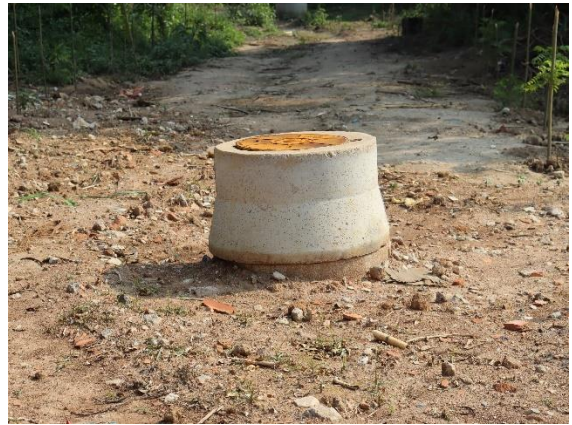
Figura TEC 12 – Extensão de interceptador Casa Branca (Fonte: DAE Jundiaí)
