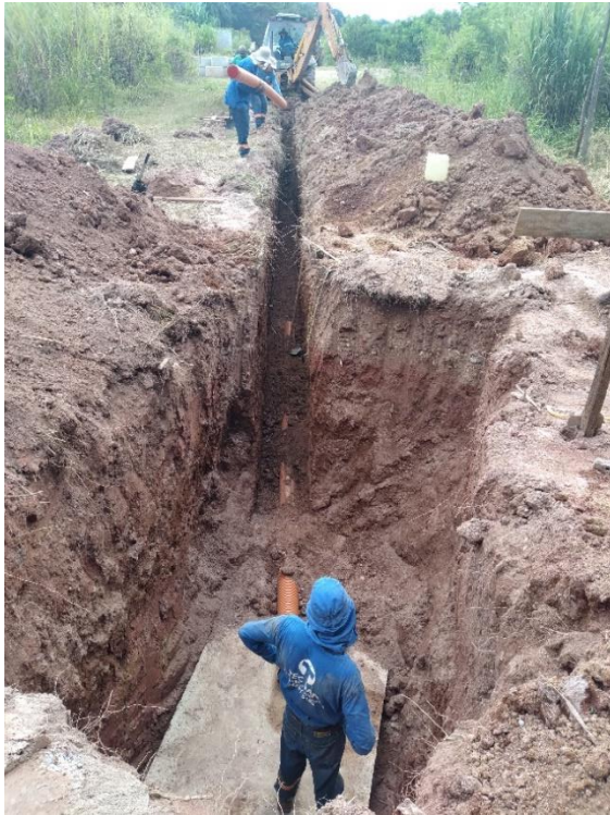
Figura TEC 9 – Extensão de interceptadores e rede coletoras Travessa Fazendinha (Fonte: DAE Jundiá)
