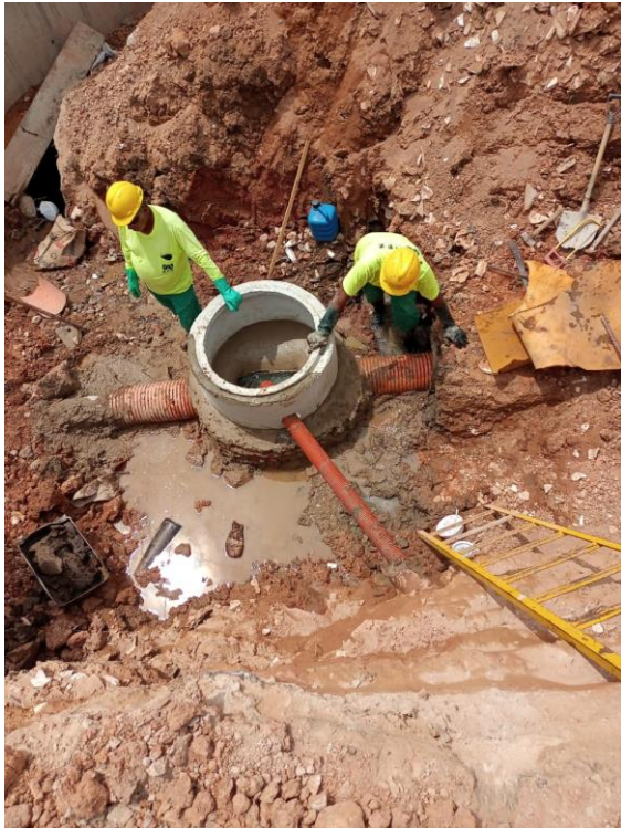
Figura TEC 5 – Extensão de interceptadores e rede coletoras Marginal do Vencedor (Fonte: DAE Jundiaí)
