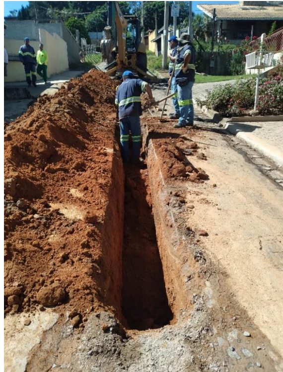
Figura TEC 9 – Extensão de interceptadores e rede coletoras Travessa Fazendinha (Fonte: DAE Jundiá)
