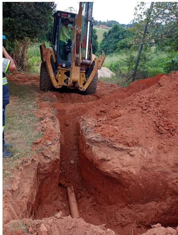
Figura TEC 8 – Extensão de interceptadores e rede coletoras Rua Michelim (Fonte: DAE Jundiá)
