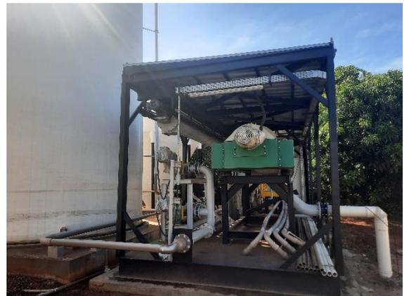
**Figura TEC 1 – Sistema de desidratação de lodo da ETA em construção**
