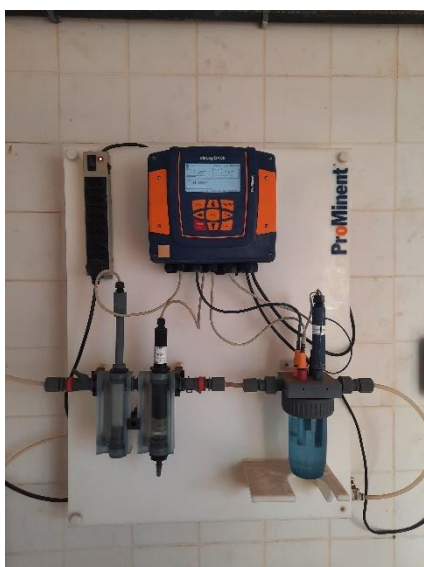
Figura TEC 15 -Automação da dosagem de cloro, flúor e medição de pH no Poço Jardim Iraja II
