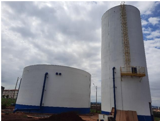
Figura TEC 3 -Reservatórios e elevatória Heitor Rigon (2.000 m 3 e 500 m 3 )
