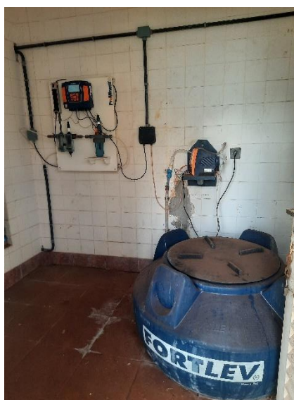
Figura TEC 15 -Automação da dosagem de cloro, flúor e medição de pH no Poço Jardim Iraja II
