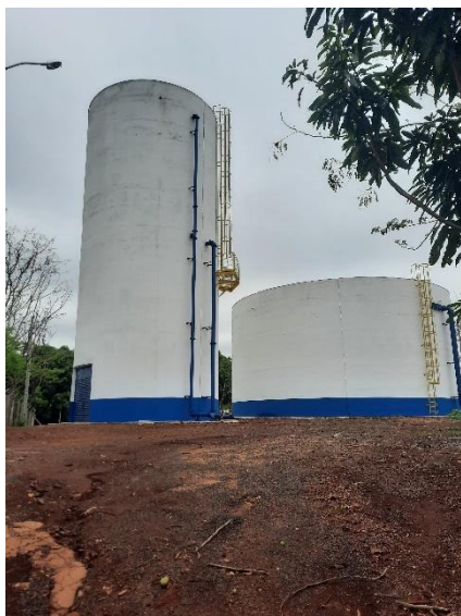
Figura TEC 1- Reservatórios Ribeirania (2.000 m 3 e 300 m 3 ) no Ribeirânia e trecho da adutora substituída
