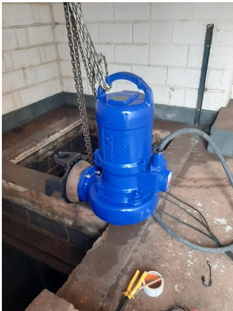
Figura 3. Compra de 1 (uma) bomba BBA KSB AMAREX KRT K 100-253/184 UEG / 25CV 220 + KIT FIXO Q=228 M3/H HM=20 MCA ROTOR 251 MM para a ETE.
