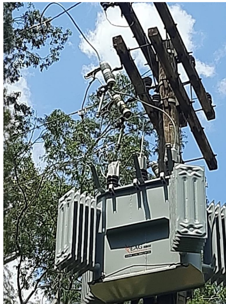
Figura 2. Compra de 1 (um) Transformador trifásico 112,5KVA 220/127V para a ETA.
