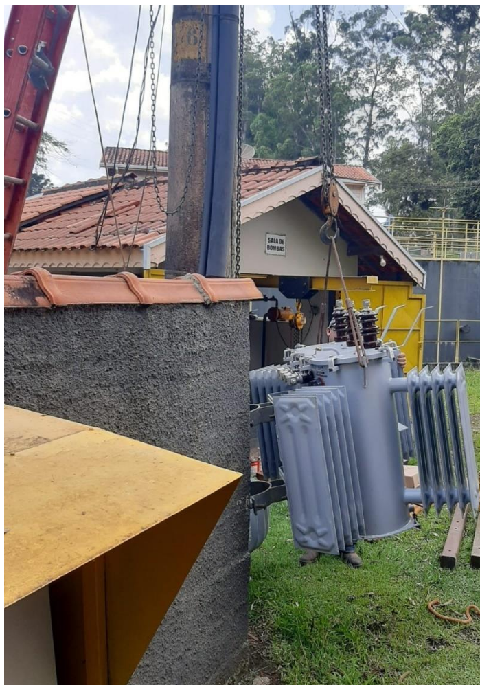
Figura 2. Compra de 1 (um) Transformador trifásico 112,5KVA 220/127V para a ETA.
