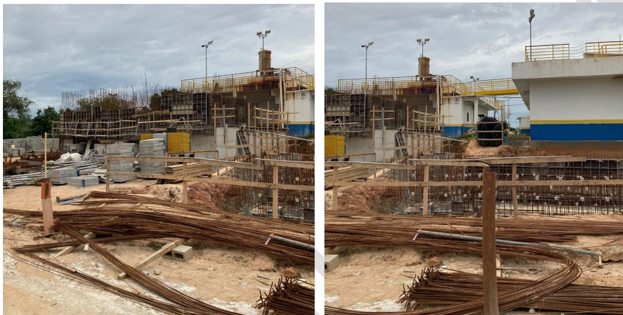
Figura 7. Ampliação da ETA Central em 50 L/s - Fase 1 - 5ª unidade. Construção da Casa de Química.
