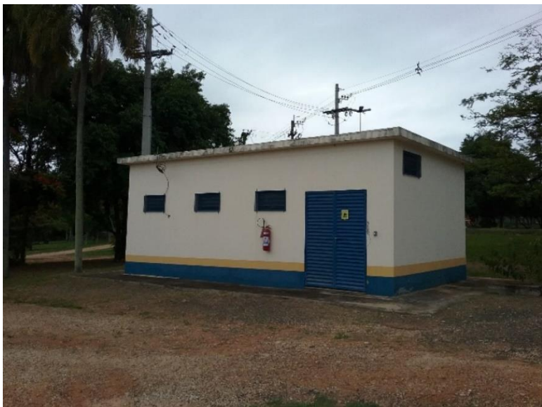
Figura 2. Cabine Primária ETE Camanducaia
