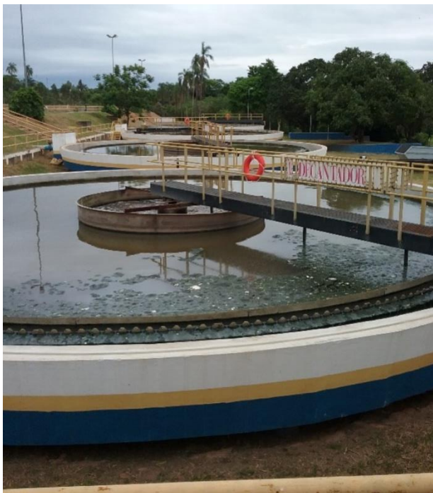
Figura 3. Manutenção civil dos decantadores da ETE Camanducaia.
