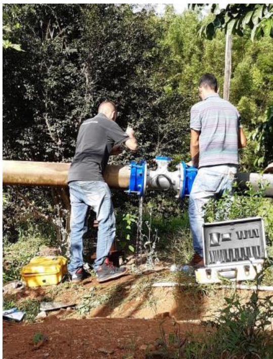
Figura 4. Implantação do Projeto de combate a Perdas de água com fornecimento de macromedidor de entrada na ETA do Lageado e substituição de micromedidores (HD)
