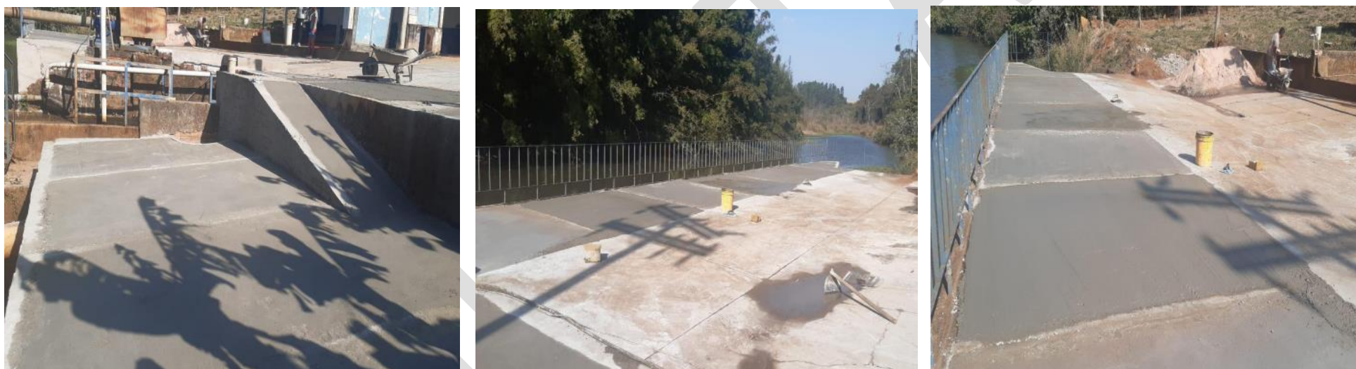
Figura 5. Reforma na ETA Lajeado.
