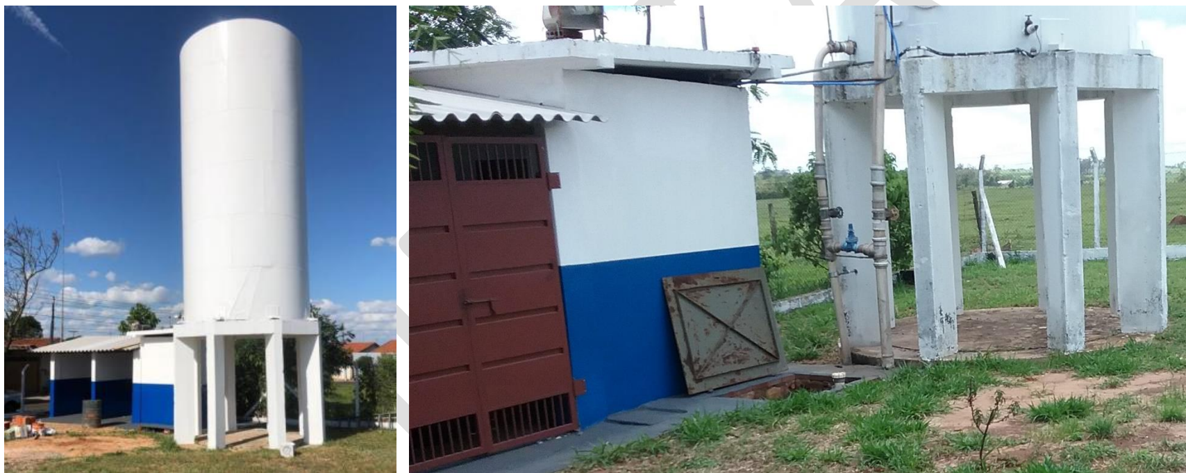
Figura 6. Reforma do Reservatório CDHU.
