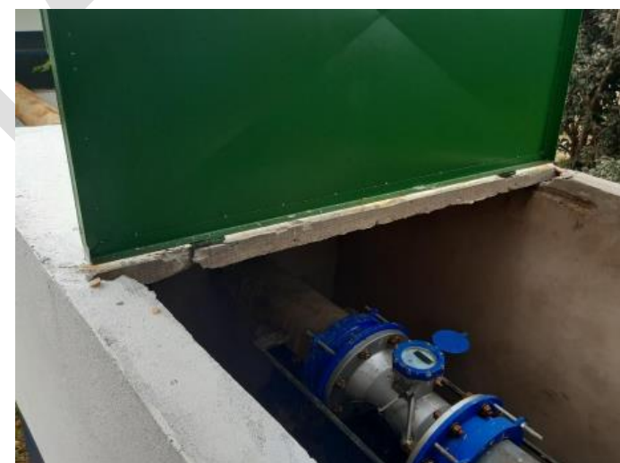
Figura 4. Implantação do Projeto de combate a Perdas de água com fornecimento de macromedidor de entrada na ETA do Lageado e substituição de micromedidores (HD)
