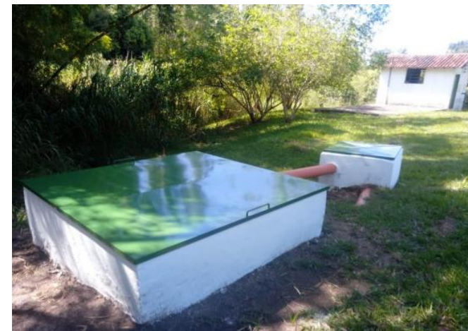
Figura 3. Construção de caixas de limpeza para o Dreno em Guarapuã
