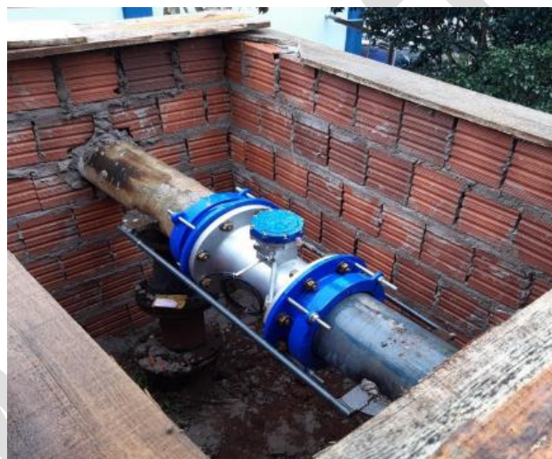
Figura 4. Implantação do Projeto de combate a Perdas de água com fornecimento de macromedidor de entrada na ETA do Lageado e substituição de micromedidores (HD)
