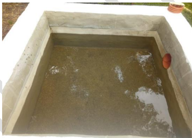
Figura 2. Construção de caixas de limpeza para o Dreno em Guarapuã
