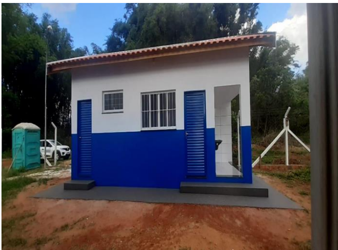
Figura 1. Construção de abrigo na ETE
