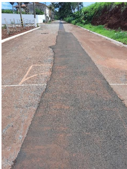
Figura TEC 4 - Rede rede de água \varnothing 150 mm na Cachoeira de Emas da setorização
