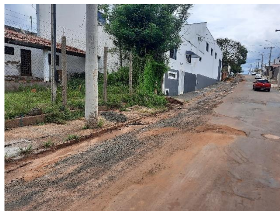
Figura TEC 3 - Rede de Jd. Petrópolis \varnothing 150 mm
