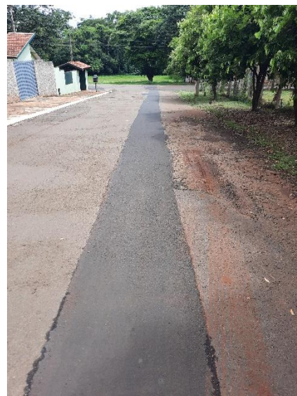
Figura TEC 4 - Rede rede de água \varnothing 150 mm na Cachoeira de Emas da setorização
