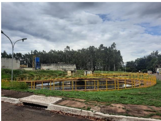
Figura TEC 5 - Substituição dos guarda-corpos da ETE Laranja Azêda
