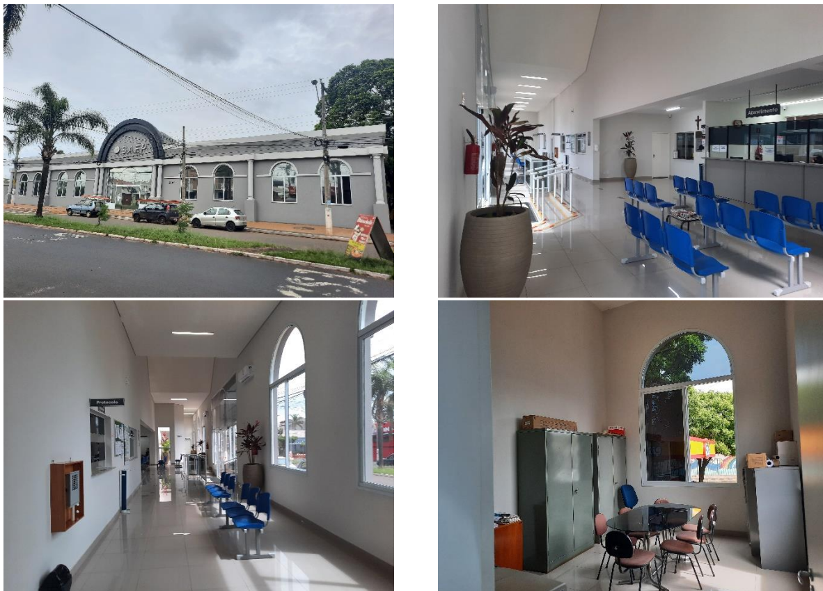
Figura TEC 1 - Reforma e ampliação do prédio administrativo
