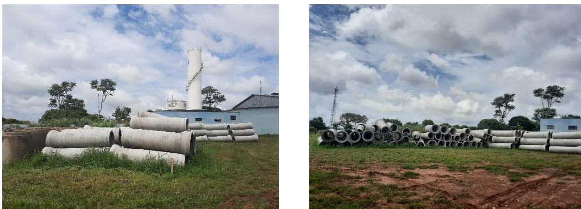
Figura TEC 2 - Tubos de concreto \varnothing 600 mm para 1ª etapa do interceptor de esgoto da zona Leste
