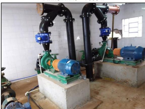
Figura 5 – Item 5.1 – Adequações de redes adutoras na ETA Central e infraestrutura para instalação de bombas reservas.
