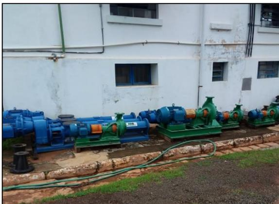
Figura 7 – Itens 2.5 e 6.2 – Conjuntos motobombas aguardando instalação.
