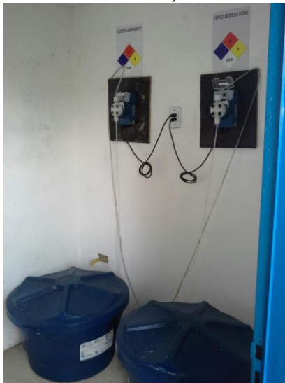
Dosagem de cloro e flúor do Poço Espírito Santo
