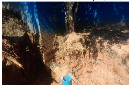
Projeto 7 - Implantação da Rede DN 150mm FoFo – Camargo, Cuba e Centro (abr/2019)
