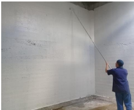
Impermeabilização interna RS Camargo
