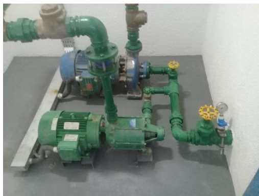
Novos conjuntos moto-bomba da EEAT São Guido
