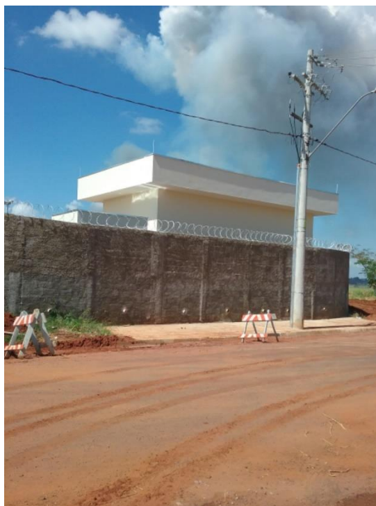
Figura 5 - Novo reservatório, e poço no CR Selmi Dei II. Detalhe para demarcação da adutora que ligará o CR ao sistema São Rafael
