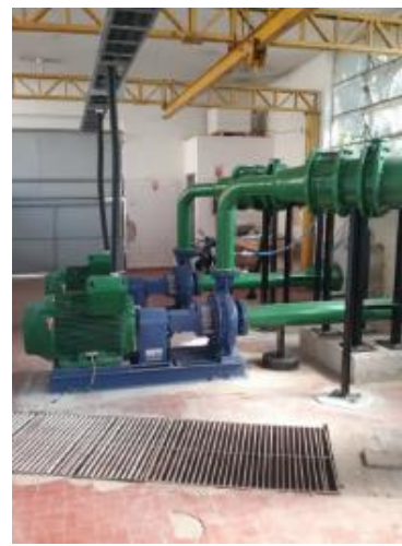
Figura 1 a 3 - Bombas de recalque da ETA João Jabour, reforço da barragem João Jabour e Reservatório Novo Jd. Buru.
