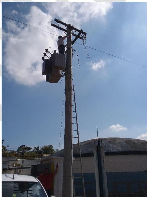
**Figura 3 - Novo padrão de entrada da ETA sendo instalado**
