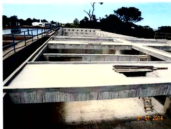
Figura 14 – Obras ampliação ETA II - Floculadores
