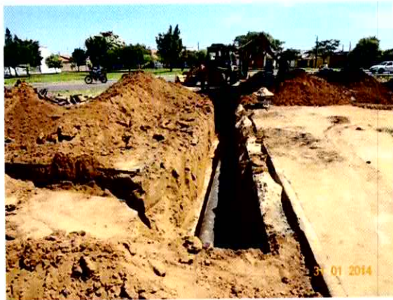
Figura 16 - Obras da chegada da adutora
