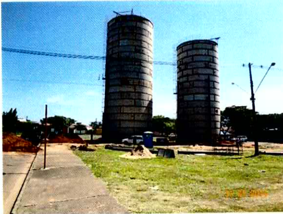
Figura 15 – Vista Geral dos reservatórios
