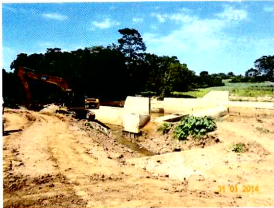
Figura 10 – Vista Geral da barragem de regularização
