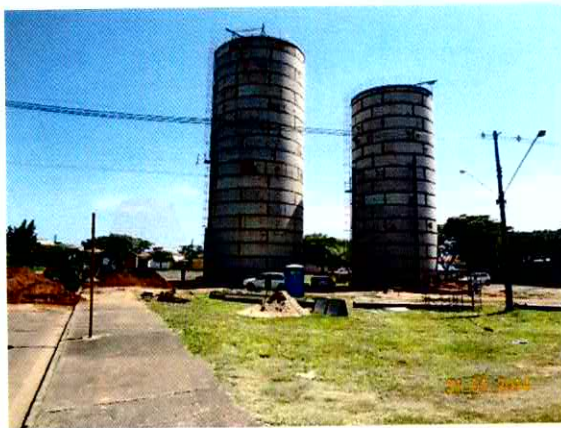
Figura 17 – Vista Geral dos reservatórios
