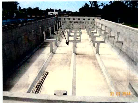
Figura 13 – Obras ampliação ETA II - Decantador
