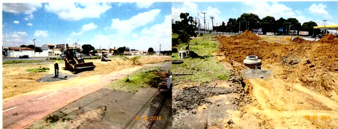
Figura 19– Obras Coletor Tronco na Avenida Brasil
