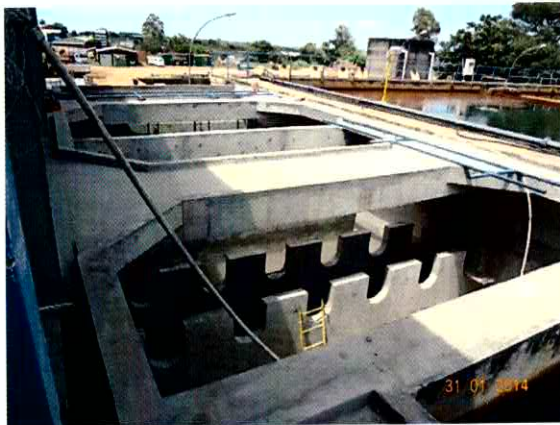
Figura 12 – Obras de ampliação ETA II - Filtros
