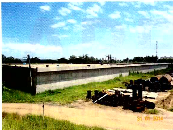
Figura 07- Reservatório da Central de distribuição onde foi realizado obras de impermeabilização
