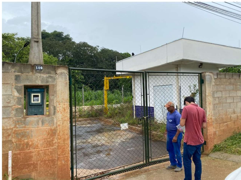
Elevatória de Esgoto do Distrito Industrial (Coim)
