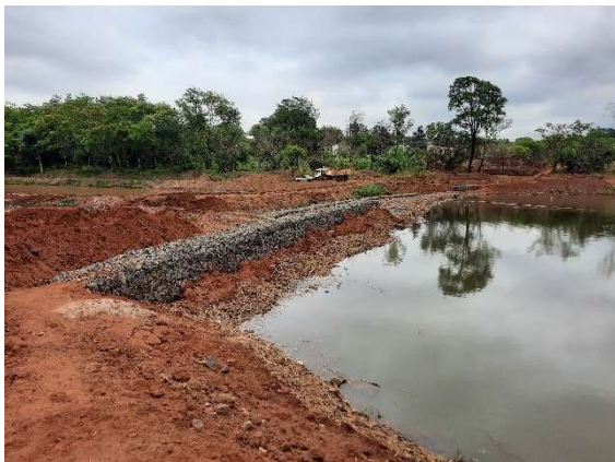
Figura TEC 8 – Desassoreamento e execução da bacia de retenção de sólidos da captação do Ribeirão das Cruzes
