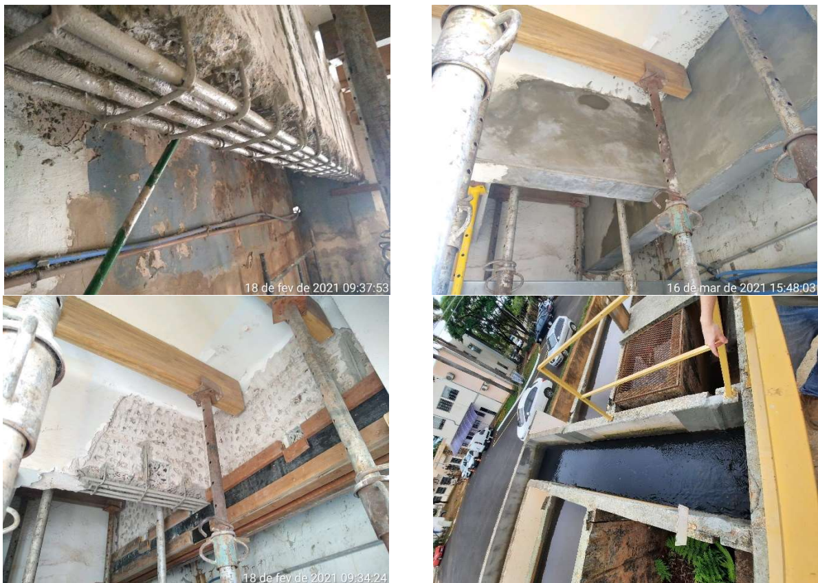
Figura TEC 6 - Recuperação Estrutural de vigas e pilares do prédio e reparo dos vazamentos da ETA Fonte
