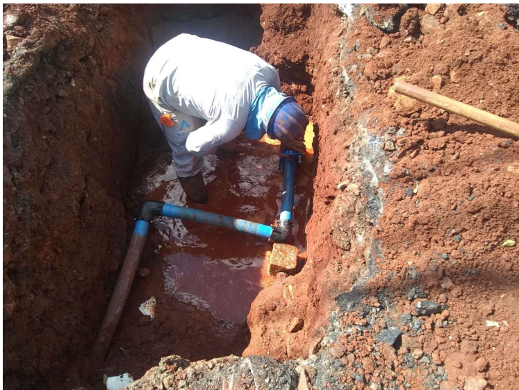
Figura TEC 7 - Execução de troca de redes e ramais de água
