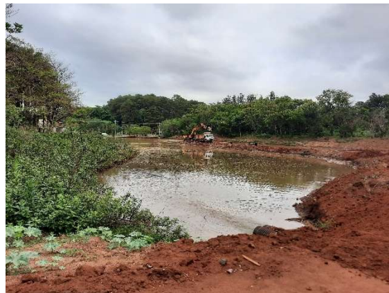
Figura TEC 8 – Desassoreamento e execução da bacia de retenção de sólidos da captação do Ribeirão das Cruzes
