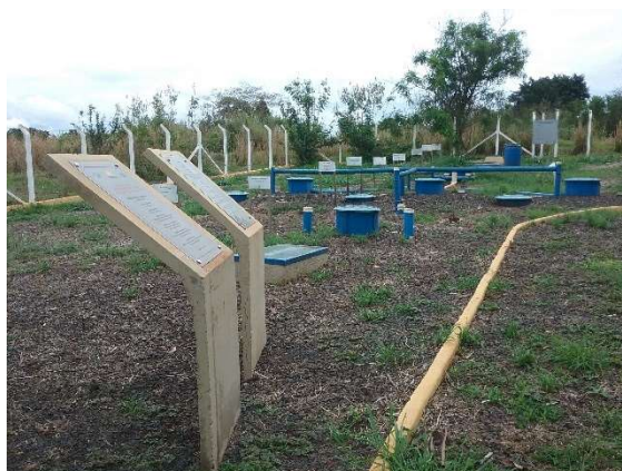
Figura TEC 10 – Adequações na ETE Compacta Assentamento Bela Vista
