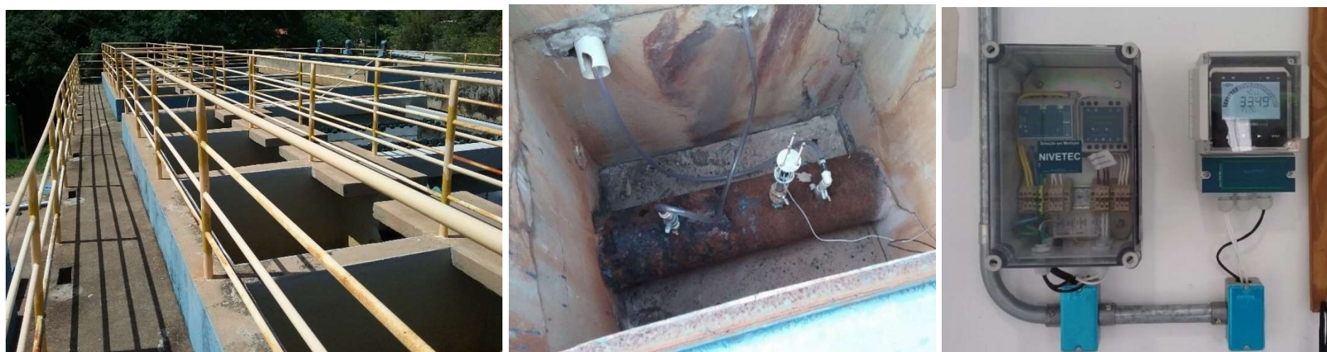
Figura 3. Adequações na ETA II: guarda-corpos e macromedidor.
