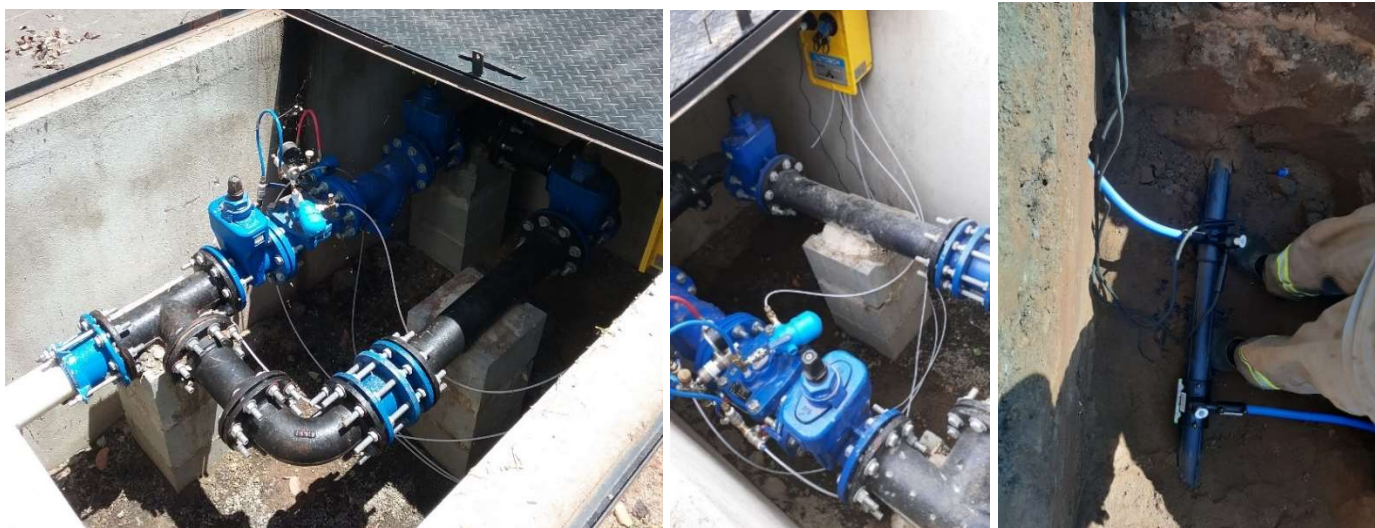
Figura 10. Implantação de ações de combate a perdas de água: instalação de VRP, setorização e troca de rede.
