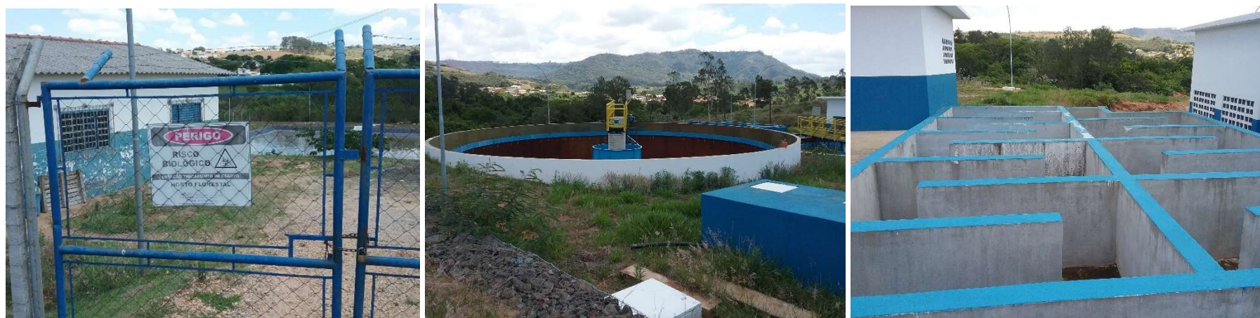
Figura 9. ETE do Horto: obras em execução (paralisadas devido à pandemia).
