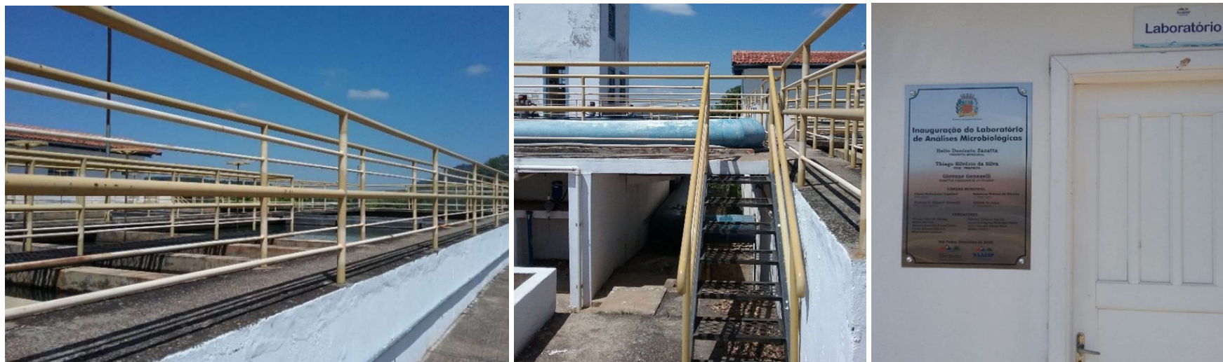
Figura 2. Adequações em guarda-corpos e escadas na ETA I e Laboratório.
