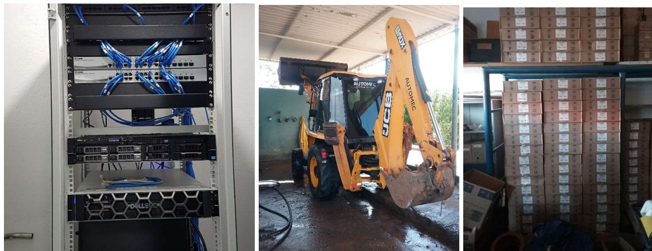
Figura 11. Equipamentos de informática, retroescavadeira e hidrômetros.
