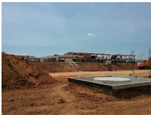
Obras de construção da ETE Balsa em 02 de outubro de 2018
