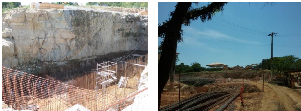
Visita técnica da ARES-PCJ às obras da nova captação em 02 de outubro de 2018
