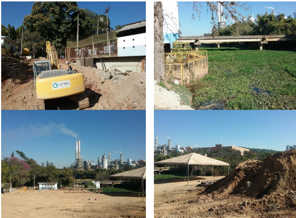
Visita técnica da ARES-PCJ às obras da nova captação em 16 de julho de 2018
