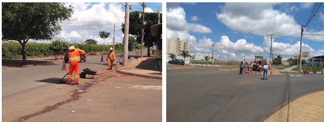
Troca de rede Capuava e Alvorada (obras em andamento)
