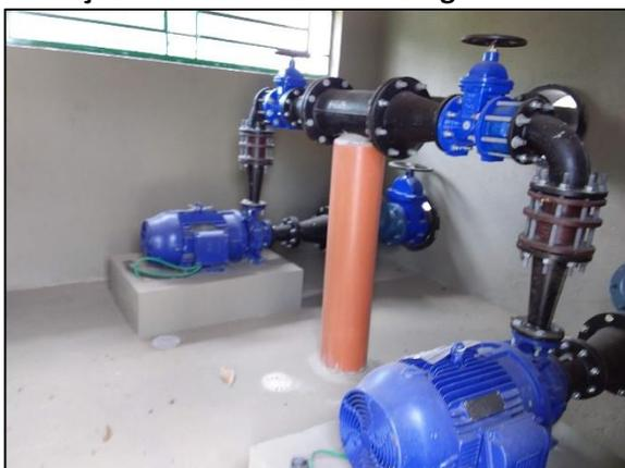
**Figura 3 – Item 3 – Abrigo, conjuntos moto-bombas, painel elétrico e automação do Booster Omizolo.**
