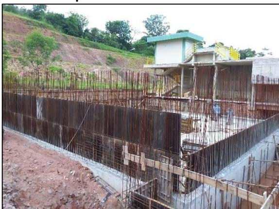
**Figura 9 – Item 9 – Construção do 4º módulo do reator anaeróbico (UASB) e recuperação do guarda corpo da estação de tratamento de esgoto de Louveira.**
