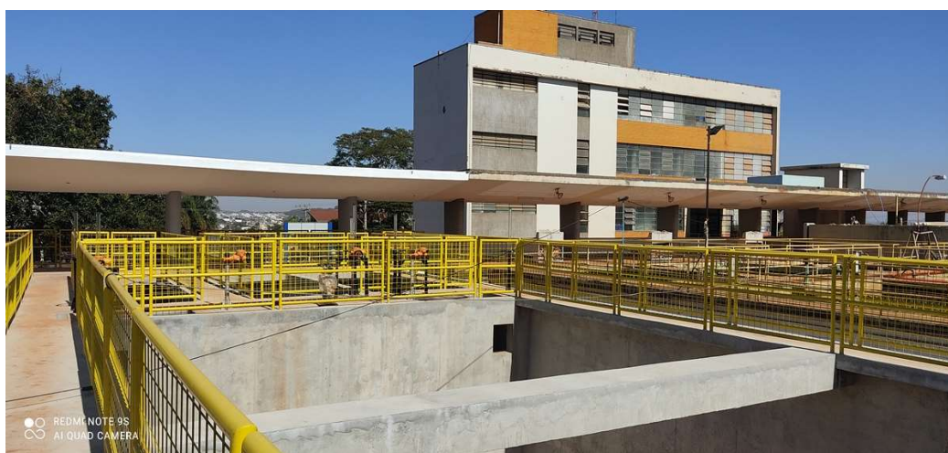
Figura TEC 2 – NOVA ESTAÇÃO TRATAMENTO DE ÁGUA - ETA 3
