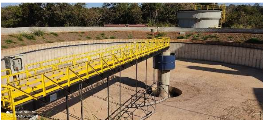
Figura TEC 3 - NOVA ESTAÇÃO DE TRATAMENTO DE ESGOTO MOGI GUAÇU - 2.ª ETAPA - AV. BRASIL
