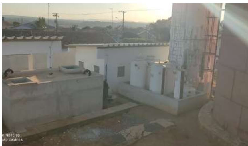
Figura TEC 6 - EXECUÇÃO DE OBRAS E SERVIÇOS DA NOVA ETA DISTRITO MARTINHO PRADO
