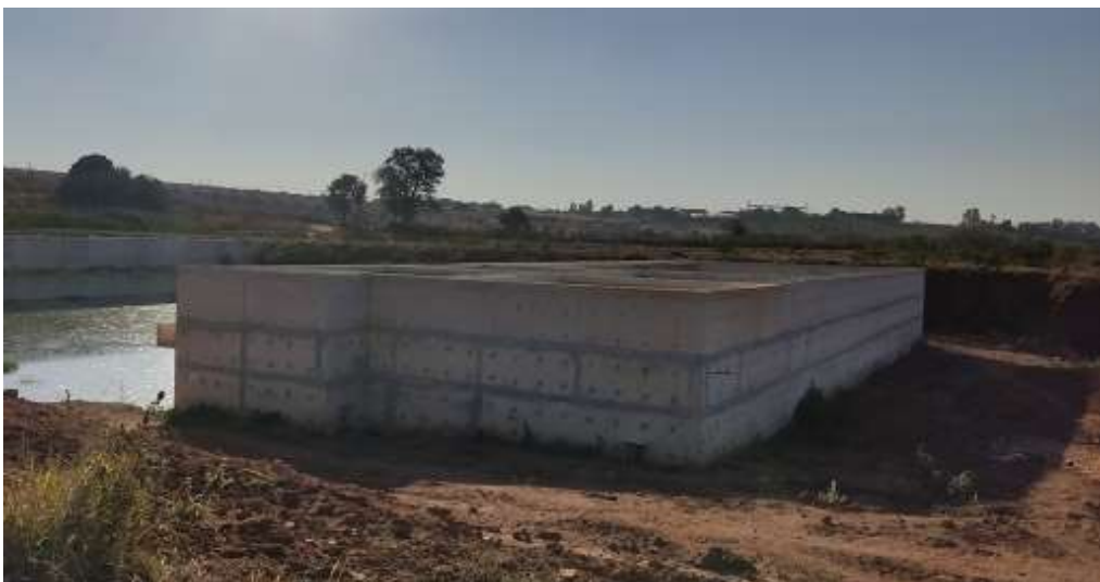
Figura TEC 5 - OBRAS DE ADEQUAÇÃO DA 1ª e 2.ª ETAPA DA ETE YPÊ.
