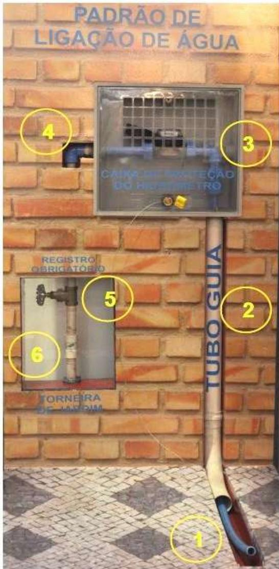
1. **Não existe mais registro de calçada:** O material PEAD flexível utilizado no novo padrão elimina vazamentos de calçada e permite a manutenção sem a necessidade de registro.
