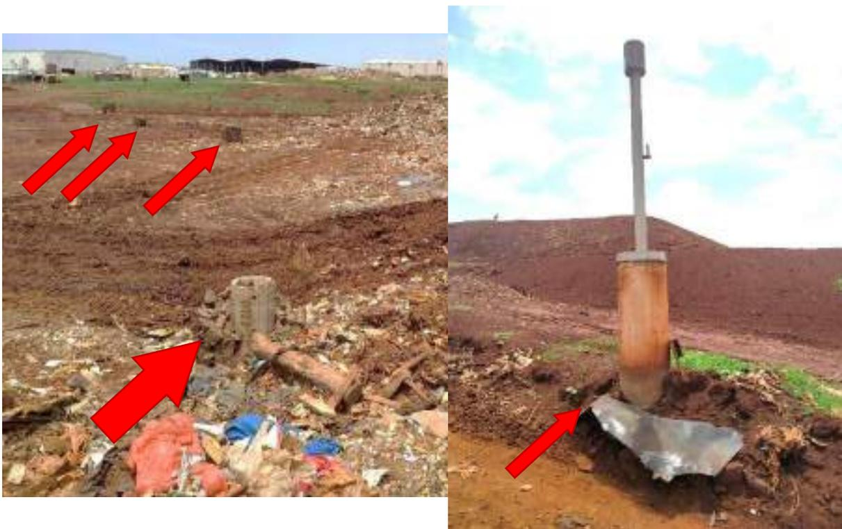
**Figura 7: Queimadores instalados no aterro sanitário.**
