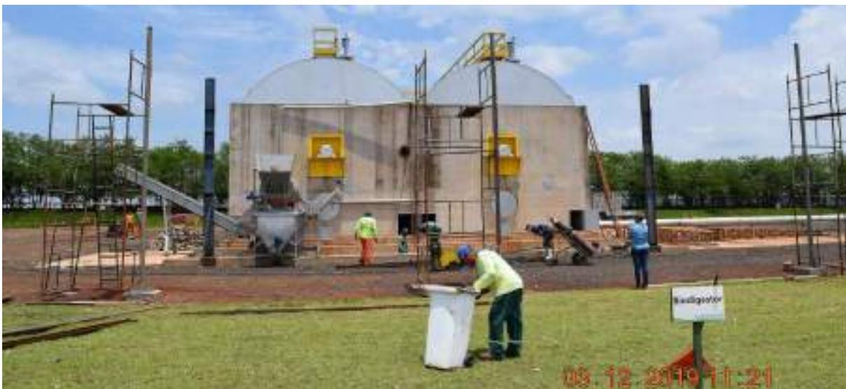
**Figura 4:** Biodigestores anaeróbios do CTR Palmeiras, evidenciando que os mesmos ainda estão em processo de instalação e ajustes. Foto da vistoria de 03.12.2019.
