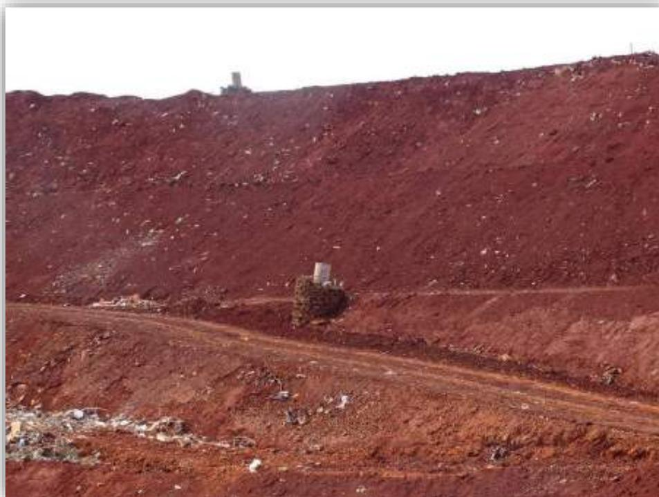
**Figura 5: Drenos do biogás gerado no Aterro.**
