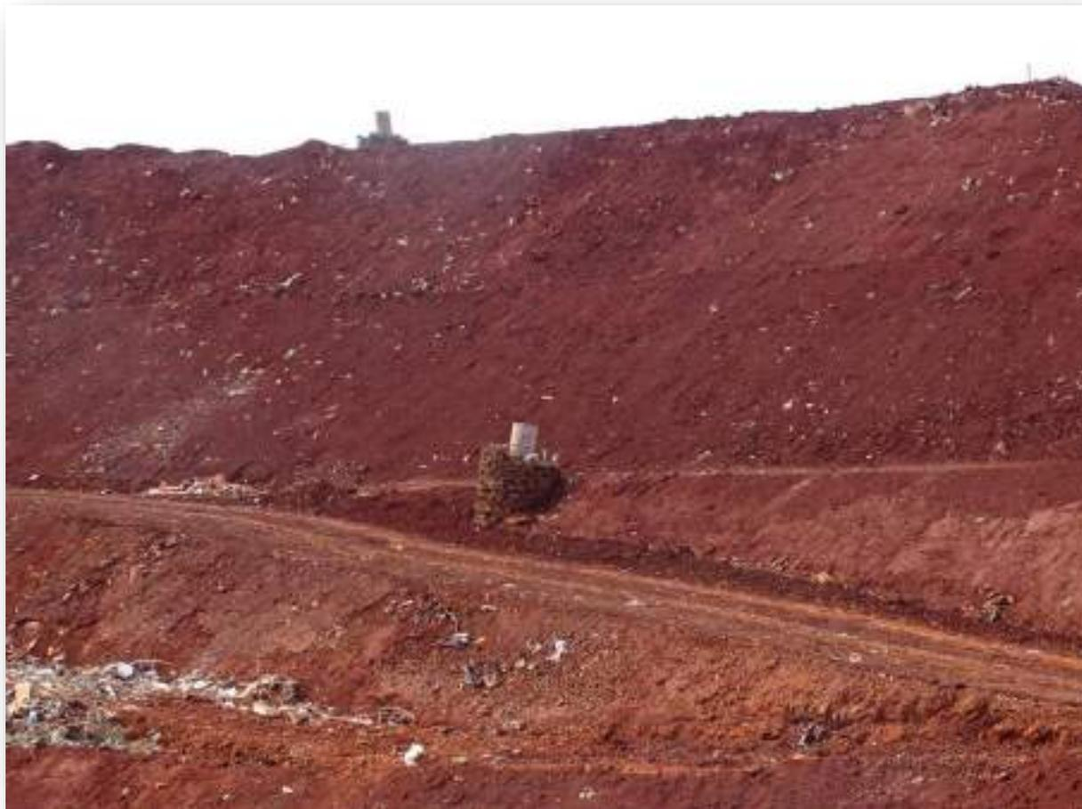
**Figura 3: Drenos verticais do biogás gerado no Aterro. Foto da vistoria de 12.06.2018.**
