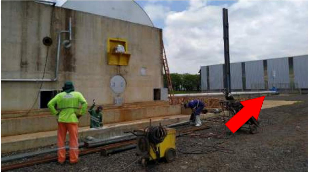
**Figura 8: Destaque para o flare instalado na proximidade dos biodigestores.**
