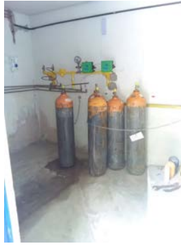
Descrição(7): Sala de armazenamento de cloro gás
