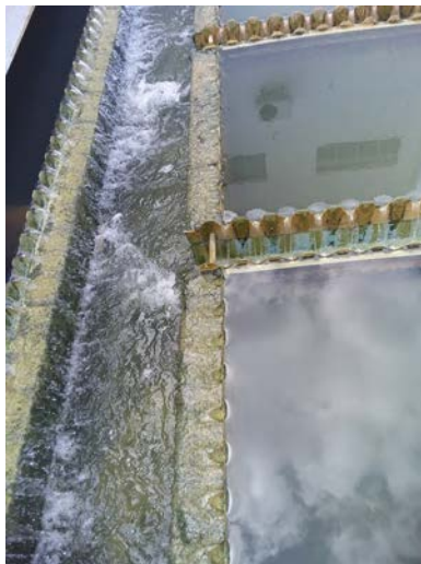
Descrição(6): Detalhe para passagem de flocos pelos vertedores
