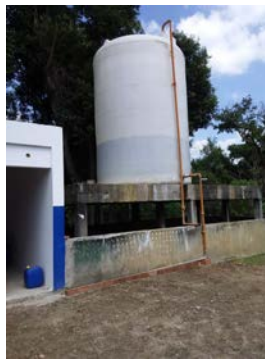
Descrição(5): Armazenamento de produtos químicos
