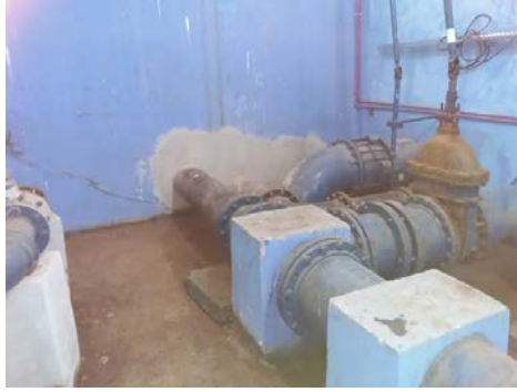
Descrição(3): Reparo realizado para correção de vazamentos
