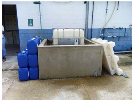
Descrição(6): Nova contenção para estocagem de produtos químicos
