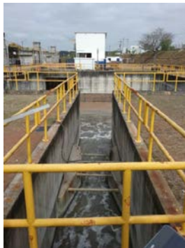
Descrição(3): Desarenador aguardando limpeza manual
