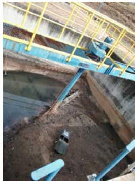
Descrição(3): Desarenador aguardando limpeza manual
