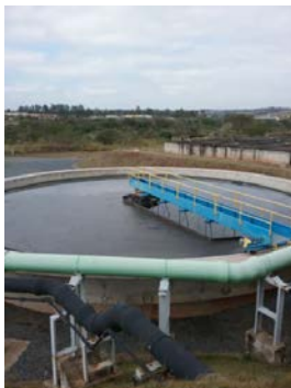
Descrição(5): Tanque de equalização e 4 conjuntos de recalque para os reatores anaeróbios (UASB)
