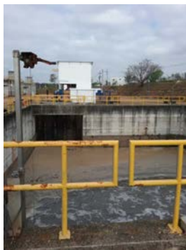
Descrição(5): Tanque de equalização e 4 conjuntos de recalque para os reatores anaeróbios (UASB)
