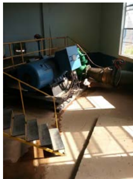
Descrição(5): conjunto moto bomba de 1000cv principal
