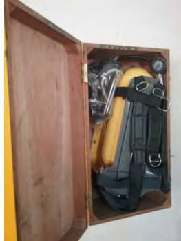
Descrição(9): Kit emergência para vazamento de cloro
