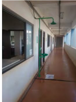
Descrição(12): Chuveiro de emergência do laboratório ETA II
