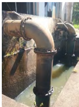
Descrição(11): Poço de sucção - Casa de bombas 2
