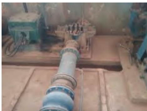
Descrição(10): Bomba em manutenção - Casa de bombas 2
