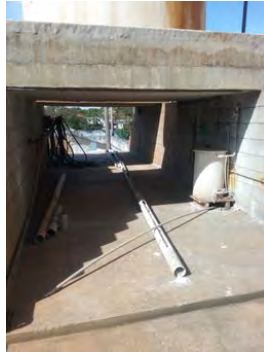
Descrição(4): Tanques de preparação de produto químico sem bacia de contenção
