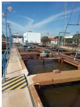
Descrição(10): Entrada de água bruta/ calha Parshall
