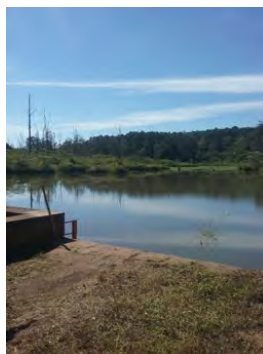
Descrição(10): Vista geral captação Ribeirão Claro
