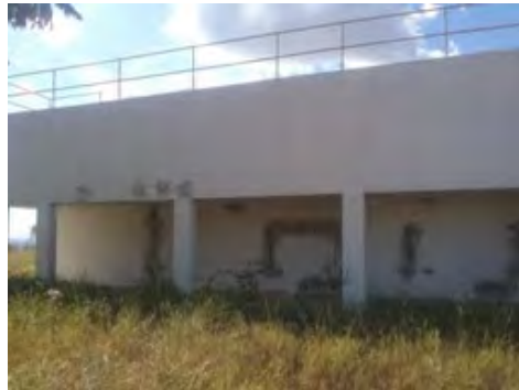
Descrição(8): Detalhe da parede externa dos tanques novos (ampliação) recém reparados
