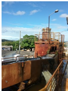
Descrição(15): Armazenamento inadequado de produto químico (sem proteção de contenção)
