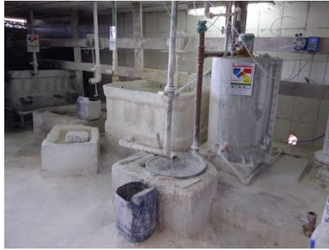
Descrição(22): Armazenamento e preparação da solução de Cal.
