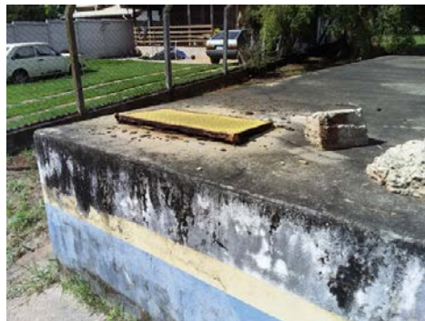
Descrição(5): Tampa do reservatório oxidada
