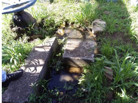
Descrição(4): Conexão rompida (aguardando para fazer manutenção)
