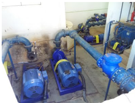
Descrição(4): Conexão rompida (aguardando para fazer manutenção)
