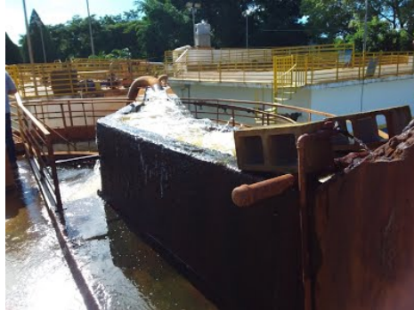
Descrição(23): Estrutura de entrada com transbordamento
