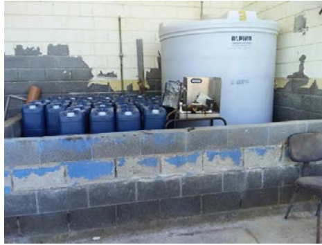
Descrição(7): Armazenamento de polímero
