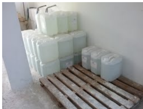
Descrição(10): armazenamento de hipoclorito Imagem(11)
