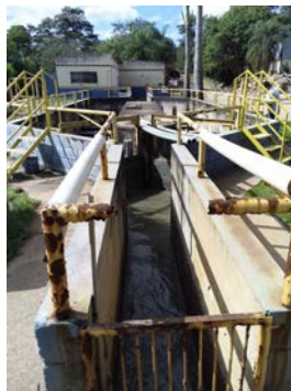
Descrição(5): Detalhe do Guarda-corpo oxidado
