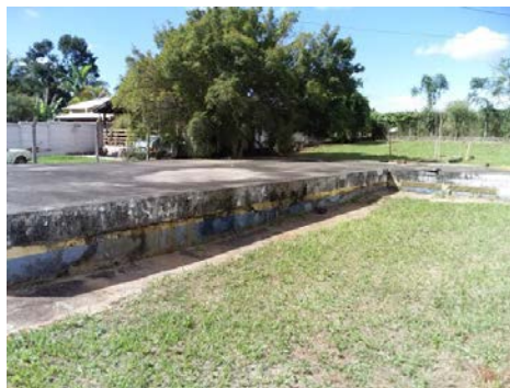
Descrição(5): Tampa do reservatório oxidada
