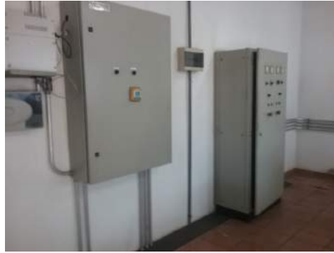
Descrição(3): Painel de comando e controle
