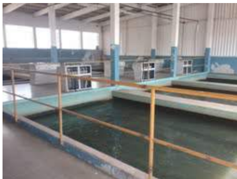
Descrição(5): Decantador e floculador ETA II
