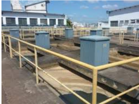
Descrição(3): Floculador decantador da ETA I
