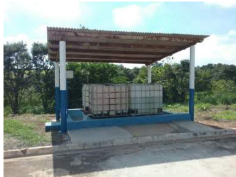
Descrição(8): Armazenamento de hipoclorito Imagem(9)
