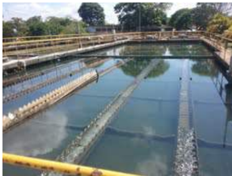
Descrição(5): Decantador e floculador ETA II
