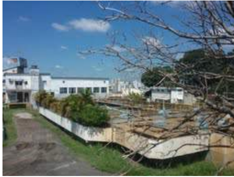
Descrição(3): Floculador decantador da ETA I
