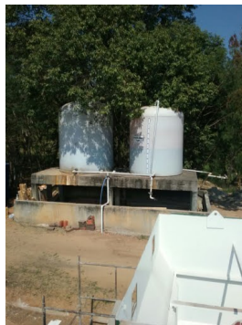
Descrição(5): Sulfato de alumínio com bacia de contenção
