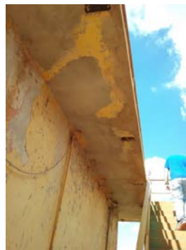
Descrição(5): Estrutura de concreto armado da ETA II - (modular), sendo recuperada. Imagem(6)
