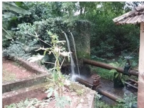
Descrição(5): Sistema de adução da água bruta da barragem com caixa d'água intermediária que alimenta os Conjuntos moto-bombas que trabalham afogadas
