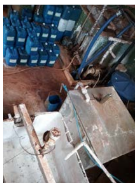
Descrição(10): Sala de química e preparação das misturas para a aplicação dos produtos no processo de tratamento pelas dosadoras
