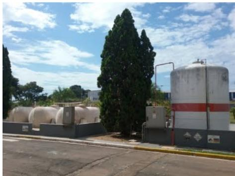
**Descrição(11):** Tanque de armazenamento do PAC e Flúor, com sistema de contenção
