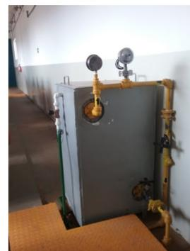
**Descrição(12):** Sistema de dosagem de gás cloro, com cilindros e evaporador.
