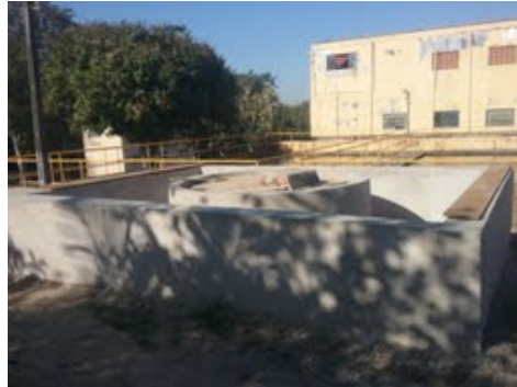
Descrição(4): Construção do sistema de contenção (flúor) Imagem(5)
