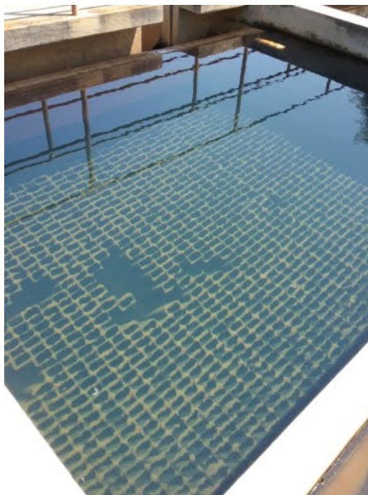
Descrição(19): Decantador com enchimento
