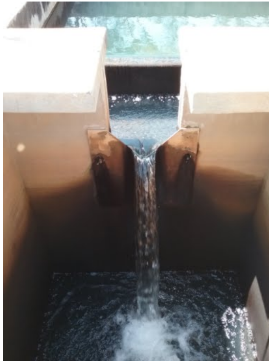
Descrição(18): Vertedor do decantador para o filtro rápido
