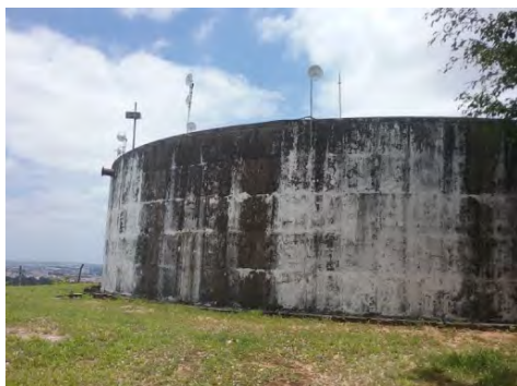
Descrição(4): Vista geral do reservatório apoiado
