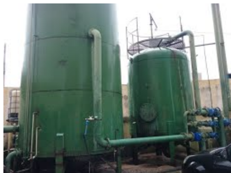
Descrição(22): Visão geral do filtro (à direita) e cloro-decantador (à esquerda).
