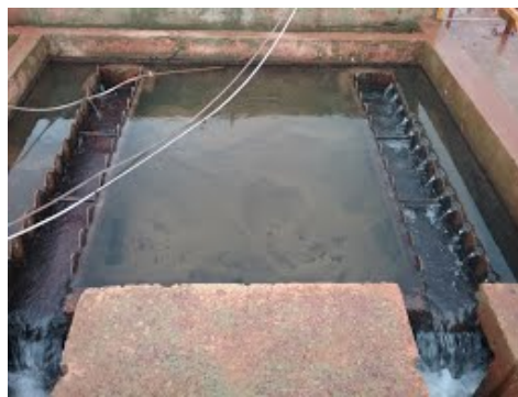
Descrição(6): Falta de limpeza e manutenção do decantador
