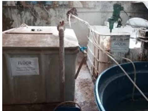
Descrição(17): Tanques da mistura de Flúor e Cal Imagem(18)
