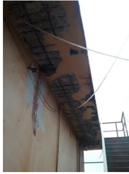
Descrição(8): Estrutura embaixo da ETA danificada
