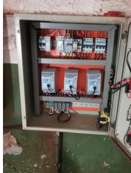
Descrição(13): Interior do painel de controle do agitador de cal
