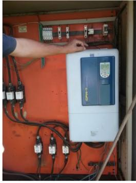
**Descrição(4):** Painel Elétrico com inversor
