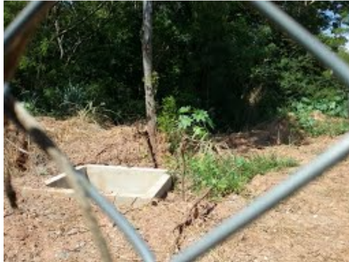
Descrição(12): Caixa de inspeção para futura instalação do macromedidor da Captação do Rio Jundiaí
