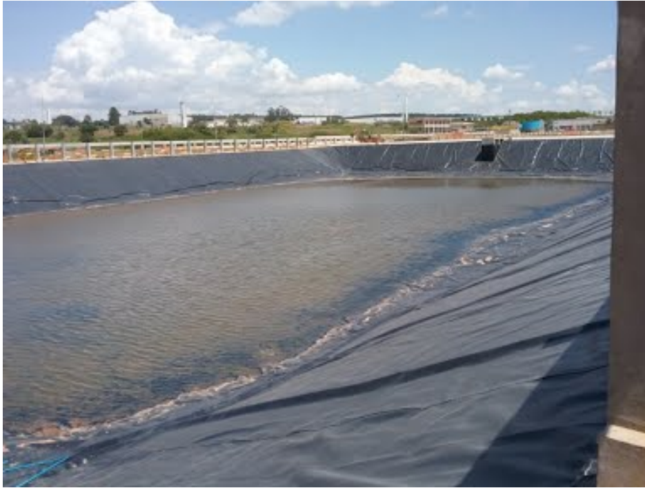
Descrição(7): Novo tanque de tratamento de esgoto de lodos ativados por aeração prolongada em construção
