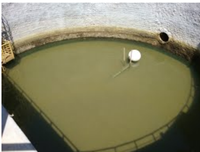
Descrição(4): Poço de reservação do lodo da ETA a ser desidratado
