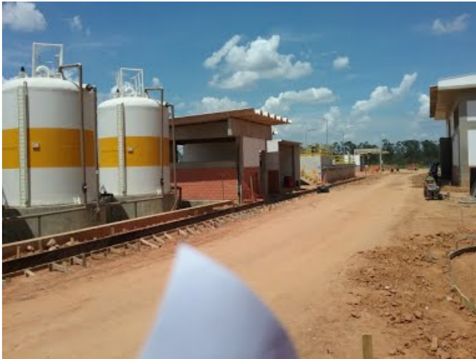
Descrição(9): Sistema de desinfecção do efluente líquido tratado sendo implantado
