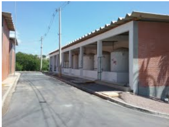
Descrição(15): Reservatórios de produtos químicos do processo de tratamento de água na ETA III
