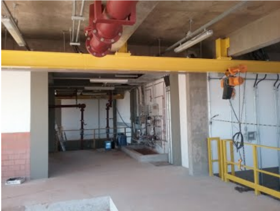
Descrição(3): Pavimento superior do módulo de desidratação do lodo da ETE
