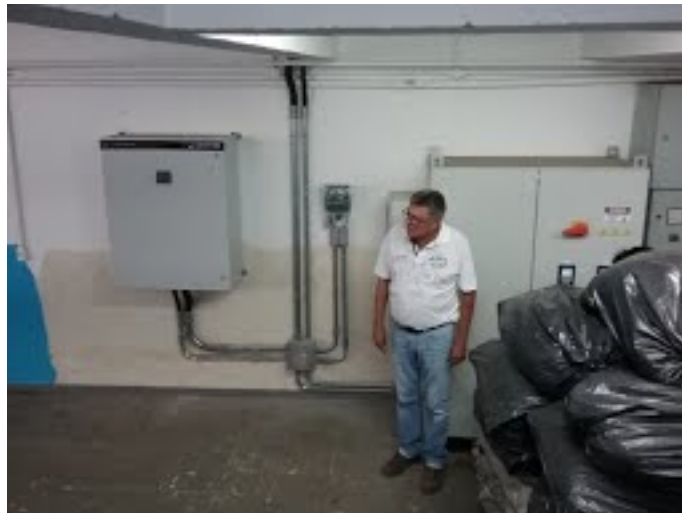
Descrição(14): Reforma das instalações elétricas da Captação do Buruzinho na ETA III
