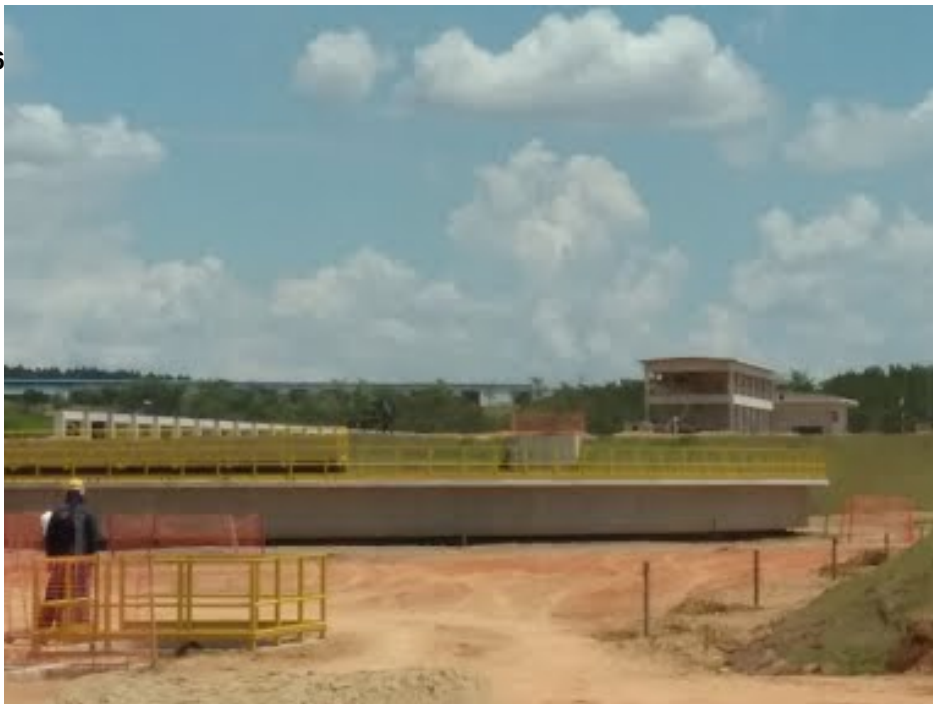
Descrição(16): Vista aproximada de um dos decantadores em construção
