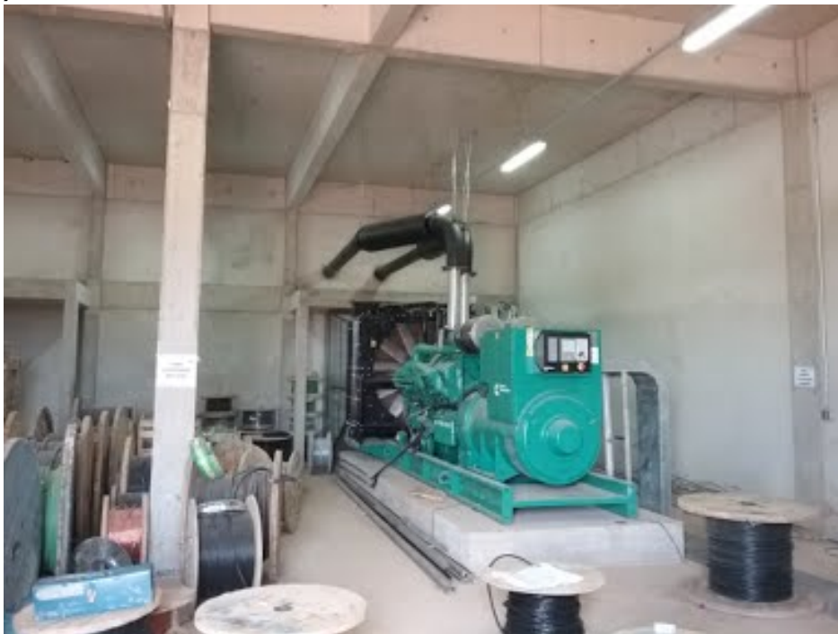
Descrição(13): Motogerador de eletricidade à diesel sendo instalado para atender aos novos módulos de tratamento
