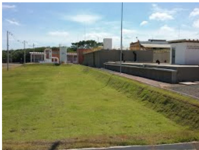
Descrição(11): Vista geral da ETA III e o terreno para futuras ampliações
