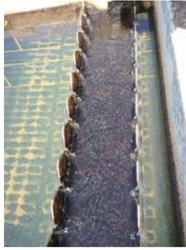
**Descrição(7):** Detalhe de um vertedor de um dos decantadores
