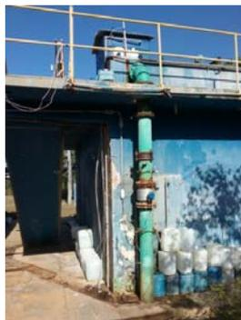
**Descrição(2):** Entrada da água bruta no módulo de tratamento da ETA 2 vindo da captação superficial no barramento do Ribeirão Água Choca situada ao lado da mesma
