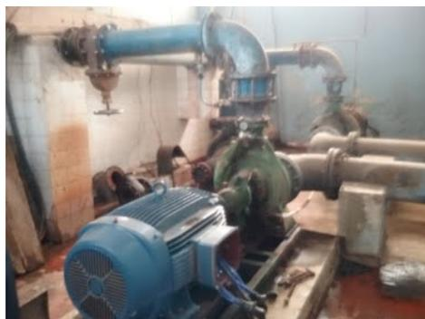
**Descrição(15):** Dois conjuntos motobombas da Elevatória de Água Tratada para o sistema PIO XII
