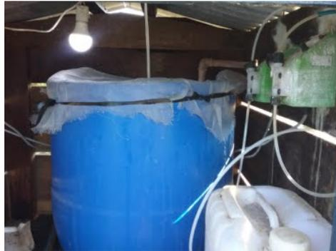
**Descrição(4):** Instalações da bomba dosadora de cloro e PAC e reservatórios dos produtos químicos protegidas no interior de um abrigo
