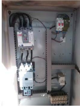
**Descrição(7):** Chaves contadoras do painel elétrico de comando dos conjuntos motobombas em quadro anexo, externo à Casa de Bombas
