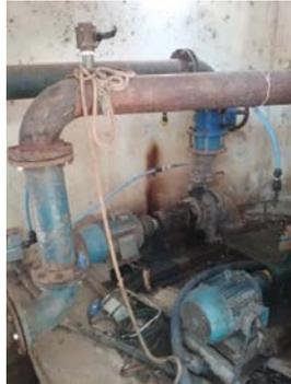
**Descrição(4):** Dois Conjuntos motobombas de sucção aspirada diretamente na barragem
