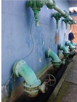
**Descrição(12):** Barrilete de manobra das vazões de descarga de fundo dos decantadores e dos filtros
