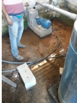
Descrição(12): EEAT - Detalhe do vazamento dentro da unidade
