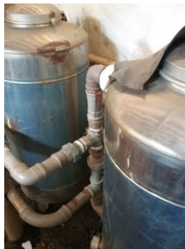
Descrição(12): EEAT - Detalhe do vazamento dentro da unidade
