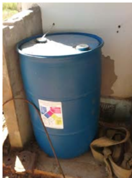
Descrição(5): Bombonas de flúor e cloro - armazenagem inadequada de produtos químicos Imagem(6)
