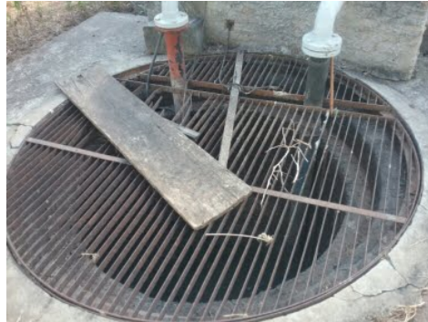
Descrição(4): Poço sucção (grade de proteção danificada)
