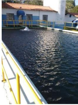
**Descrição(3):** Tanque para oxidação de Ferro e Manganês
