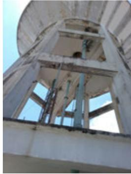
**Descrição(4):** Detalhes dos barriletes de alimentação, distribuição, do extravasor e de descarga de fundo
