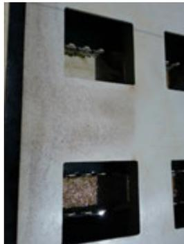
**Descrição(13):** detalhe da saída da calha de um dos reatores de lodos ativados que são enviados ao tanque de contato para a desinfecção e lançamento final
