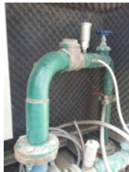
**Descrição(3):** Barriletes de sucção e de recalque com as respectivos pontos de tomadas de pressões
