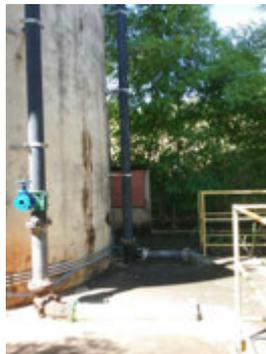
**Descrição(6):** Detalhes das tubulações de alimentação das duas câmaras de reservação
