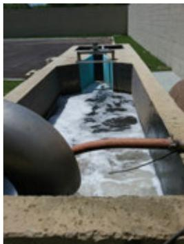
**Descrição(18):** Canal de saída do efluente tratado para o lançamento no Rio Piracicaba com calha Parshall
