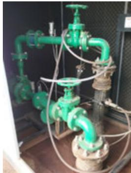
**Descrição(2):** Barriletes de sucção e de recalque do conjunto moto-bomba do Booster com as tomadas das pressões nas tubulações
