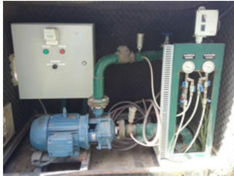
**Descrição(1):** Vista geral do Booster, conjunto moto-bomba, barriletes de sucção e de recalque com os respectivos manômetros e painel de comando elétrico do conjunto moto-bomba
