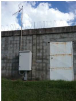
**Descrição(6):** Conjunto completo dos painéis elétricos e antena de transmissão de dados dos níveis à CCO por telemetria.
