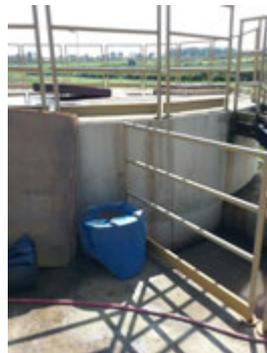
**Descrição(5):** Caixa de areia com descarga do lodo por tubulação no fundo que lança no leito de secagem
