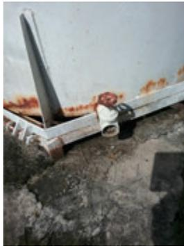
**Descrição(4):** Detalhe da base do Reservatório com uma saída de descarga de fundo
