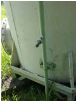
**Descrição(2):** Base do Reservatório com tubo de alimentação e tampa de inspeção
