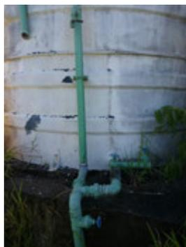
**Descrição(3):** Detalhes do barrilete de alimentação e de saída para a distribuição, interligados, pois este Reservatório é denominado como Reservatório de Sobra de água da rede pública.
