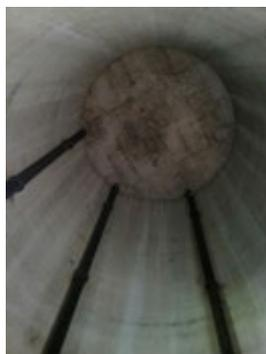
**Descrição(3):** Vista da laje de fundo do Reservatório mostrando as diversas tubulações de alimentação, descarga de fundo e distribuição, ressaltando que trata-se de um reservatório pulmão, de sobra de água da rede pública de distribuição
