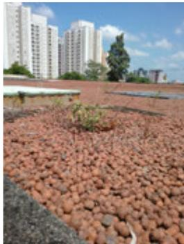
**Descrição(10):** Tampas de inspeções e argila expandida sobre a cobertura, para evitar o superaquecimento
