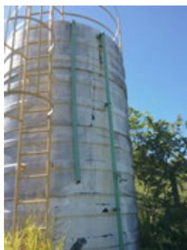
**Descrição(2):** Detalhes dos guarda-corpos, tubulações de alimentação e extravazão
