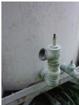
**Descrição(3):** Detalhes das saídas do Reservatório para a distribuição e outra saída para engate de mangueira para abastecimento de caminhões tanque de água
