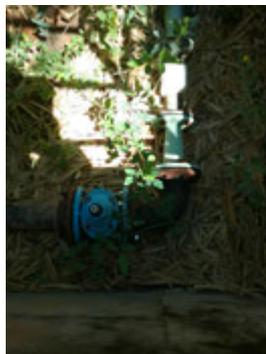
**Descrição(1):** Caixa de inspeção com registros de manobras das vazões de saída e válvula de controle de nível superior, com dados enviados e monitorados por telemetria, na CCO na Sede do SEMAE na XV de Novembro.
