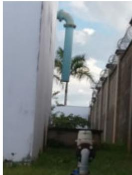
**Descrição(5):** Detalhe da falta da tela de proteção contra a entrada de insetos e pequenos animais no extravasador e o macromedidor na saída do Reservatório, antes do Booster.
