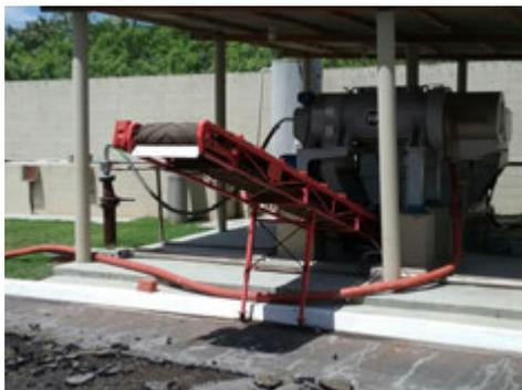
**Descrição(16):** Adensador de lodo e esteira para o carregamento dos resíduos sólidos nas caçambas para o transporte aos Aterros Sanitários licenciados pelo CADRI da ETE. No momento da vistoria estava sendo recuperado o pavimento asfáltico na via interna.
