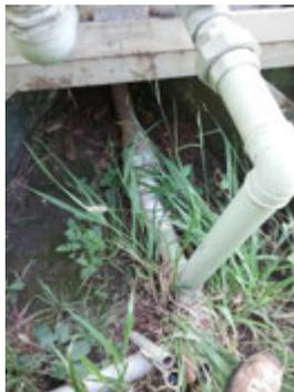
**Descrição(6):** Interligação das tubulações de alimentação e de saída para a distribuição de água para permitir o abastecimento direto com a água da rede pública sem passar pelo Reservatório
