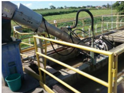
**Descrição(4):** Tratamento preliminar com gradeamento fixo e equipamento tipo rosca transportadora e limpeza do lodo do fundo do desarenadores
