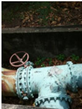
**Descrição(6):** Caixa de inspeção com registros de manobras das vazões e interligação ao barrilete de alimentação das EEATs
