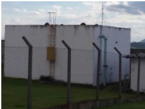
**Descrição(1):** Vista geral do Reservatório com os tubos de ventilação em cima da laje de cobertura
