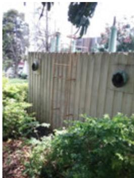
**Descrição(14):** Detalhes da caixa de distribuição de água para todos os reservatórios da Marechal Deodoro, que é alimentada pelo recalque das EEATs situadas na ETA Capim Fino
