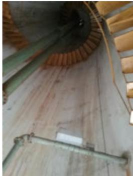
**Descrição(6):** Detalhe da tubulação de saída de água para o carregador de caminhões tanque de água potável
