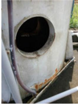
**Descrição(7):** Detalhe da abertura da inspeção sem tampa, comprovando a desativação do mesmo
