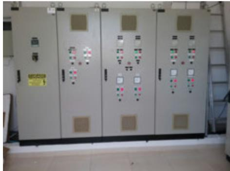
**Descrição(8):** Painéis elétricos de comando dos conjuntos motobombas da EEEB local
