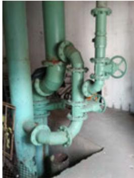
**Descrição(5):** Barrilete da interligação das tubulações de alimentação e de saída para a distribuição de água, pois trata-se de um reservatório pulmão ou de sobras de água da rede pública de distribuição
