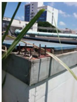
**Descrição(3):** Detalhes da tampa de inspeção e tubulação de alimentação na cobertura do Reservatório
