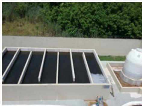
**Descrição(14):** Tanque de contato da desinfecção com hipoclorito de sódio conforme tanque de matéria prima ao lado
