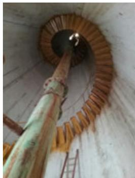
**Descrição(3):** Detalhes da escada metálica interna ao Reservatório em forma de uma espiral e do lado interno à cobertura ao centro do Reservatório
