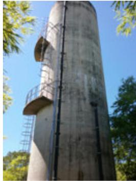
**Descrição(4):** Vista geral do Reservatório com 02 (duas) câmaras de compartimentos: superior e inferior e o detalhe da escada de acesso à cobertura do Reservatório com guarda corpos de proteção
