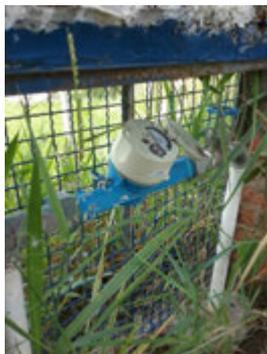
**Descrição(11):** Detalhe do hidrômetro do SEMAE que funciona como macromedidor de entrada do Reservatório
