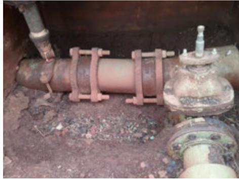
**Descrição(8):** Caixa de inspeção com tubulação de saída e alimentação do Reservatório interligados e com registro de manobras
