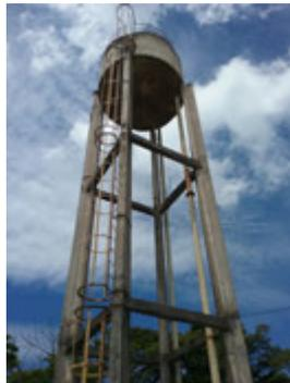
**Descrição(2):** Detalhes da escada de acesso à cobertura do Reservatório com escada com guarda corpos de proteção e tubulações de alimentação e de saída para a distribuição de água. Trata-se de um reservatório pulmão ou de sobras de água.
