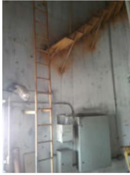
**Descrição(4):** Início da escada de acesso à cobertura do Reservatório e painéis elétricos de transmissão dos dados dos níveis pela telemetria à CCO da Sede do SEMAE.
