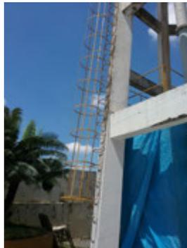
**Descrição(2):** Escada metálica de acesso à cobertura com guarda corpos de proteção
