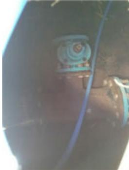
**Descrição(9):** Caixa de registro e válvula de controle de nível do compartimento inferior do Reservatório que abastece o bairro de Monte Alegre
