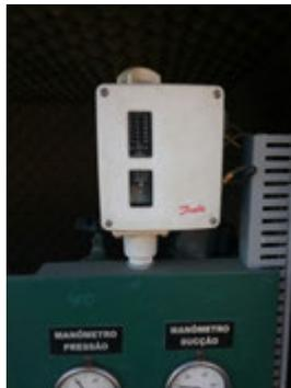
**Descrição(2):** Módulo de acionamento automático do Booster, conforme diferencial das pressões de sucção e de recalque
