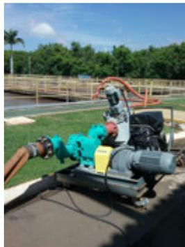
**Descrição(12):** Sistema de bombas moveis de sucção de retirada do lodo dos decantadores
