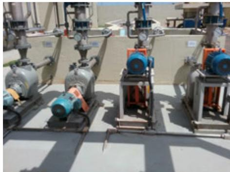
**Descrição(9):** Outra vista dos conjuntos motobombas da EEEB e detalhes das tubulações de sucção da caixa de esgoto bruto e das tubulações de recalque
