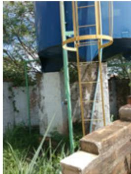
**Descrição(1):** Base do Reservatório e detalhes das tubulações de alimentação e de saída para a distribuição de água e escada de acesso à cobertura do Reservatório com guarda corpos de proteção
