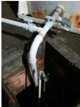
**Descrição(5):** Detalhes da caixa de inspeção com a saída da distribuição e uma torneira interligação à rede de distribuição do bairro e fomos informados que este Reservatório está desativado
