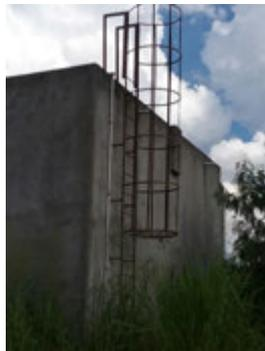
**Descrição(2):** Detalhe da escada de acesso à cobertura com guarda-corpos de proteção
