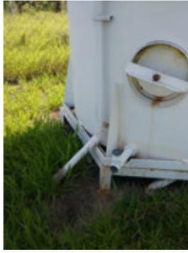
**Descrição(4):** Tampa de inspeção e tubulações de descarga de fundo e alimentação
