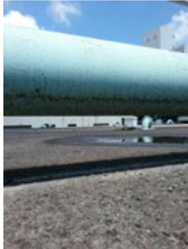
**Descrição(5):** Cobertura do Reservatório semienterrado com tubulação de ventilação
