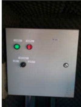
**Descrição(6):** Quadro de energia elétrica e de comando do conjunto motobomba do Booster
