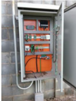
**Descrição(5):** Painel de comando elétrico dos equipamentos de medição de níveis e transmissão de dados da telemetria à CCO na Sede do SEMAE na XV de Novembro
