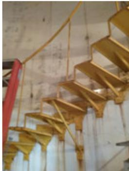
**Descrição(6):** Detalhes dos degraus da escada metálica, em espiral, de acesso à cobertura do Reservatório
