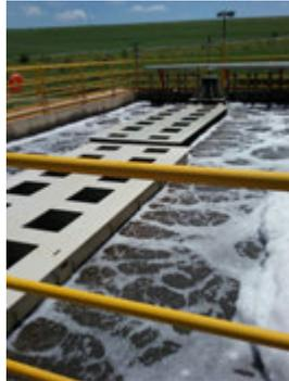
**Descrição(12):** Cobertura de um dos módulos de tratamento compacto "UBOX" com aeração prolongada de fluxo ascendente
