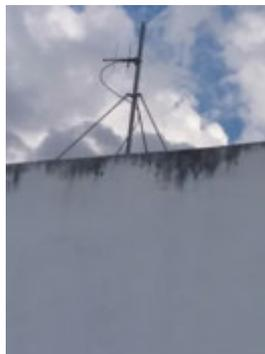
**Descrição(6):** Antena de envio de dados das vazões e níveis do reservatório, por telemetria, à CCO da Sede do SEMAE
