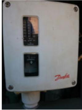
**Descrição(9):** Módulo de comando de acionamento automático do conjunto moto-bomba por diferença de pressões de sucção e recalque
