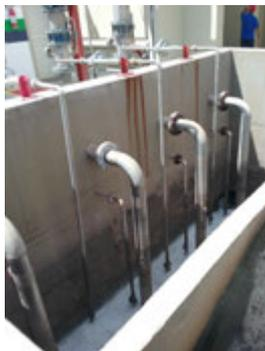
**Descrição(6):** Caixa de sucção do esgoto bruto pela EEEB local para recalque aos Reatores Compactos Anaeróbios/Aeróbios
