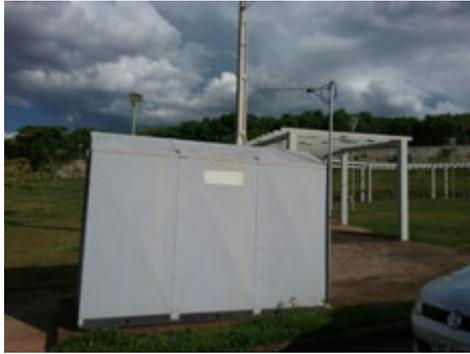
**Descrição(4):** Casa de bombas modular, metálica, que abriga também o painel de comando elétrico do conjunto moto-bomba do Booster
