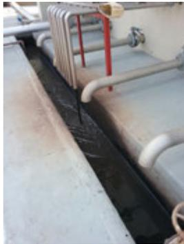
**Descrição(15):** Canaleta para descarga de fundo do lodo de esgoto tratado dos módulos de tratamento para o posterior adensamento e desidratação e destinação dos resíduos sólidos ao Aterro Sanitário licenciado
