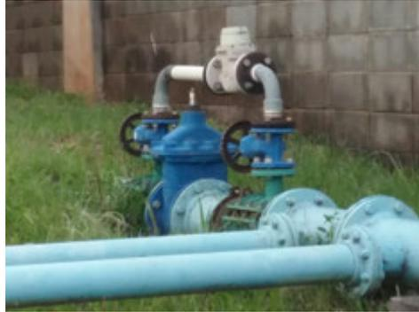
**Descrição(1):** Detalhes do barrilete de alimentação da EEAT pelo Reservatório local. Mostra o macromedidor (hidrômetro), na saída do Reservatório e antes da EEAT Local que funciona como um Booster de pressurização da rede de distribuição de abastecimento dos pontos mais altos.
