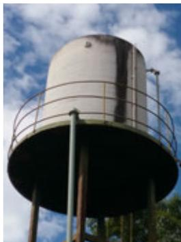
**Descrição(2):** Detalhes das tubulações de alimentação e de saída para a distribuição de água, além do tubo de medição de nível. Também mostra o guarda-corpos na plataforma da base do Reservatório
