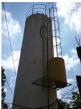
**Descrição(1):** Vista geral do reservatório com guarda corpos na cobertura e na escada de acesso e tubulação de alimentação
