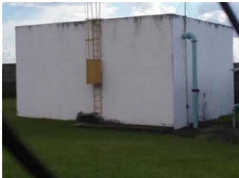
**Descrição(2):** Escada de acesso à cobertura do Reservatório com guarda corpos de proteção e tubulação de alimentação do Reservatório
