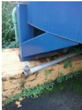
**Descrição(2):** Base do Reservatório com detalhes das tubulações de descarga de fundo e de saída para a distribuição
