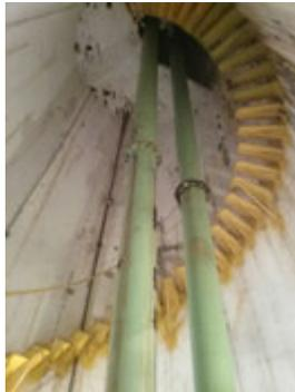
**Descrição(2):** Interior da base do Reservatório com escada metálica de acesso à cobertura do Reservatório e tubulações de alimentação e de saída para a distribuição
