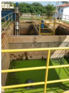
**Descrição(9):** Leito de secagem e retirada do lodo da caixa de areia do tratamento preliminar
