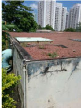
**Descrição(12):** Detalhes da tubulação de alimentação e de uma tampa de inspeção na cobertura do Reservatório
