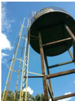
**Descrição(3):** Detalhes da escada de acesso à cobertura do Reservatório com escada com proteção de guarda-corpos e da estrutura metálica dos pilares e vigas da base do Reservatório
