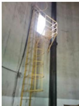
**Descrição(2):** Vista no interior da estrutura da base do Reservatório com os detalhes do início da escada de acesso à cobertura do Reservatório que na altura do alçapão possui uma plataforma de transição para a continuidade da escada pelo lado externo ao Reservatório
