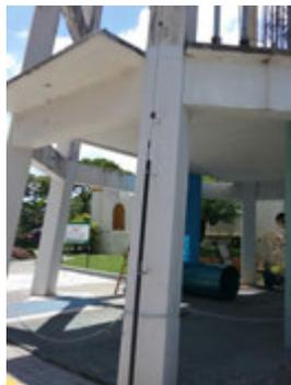
**Descrição(3):** Estrutura de concreto armado da base do Reservatório e o detalhe do cabo de aterramento do pára-raios
