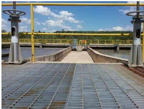
**Descrição(20):** Caixa distribuidora para entrada nos reatores aeróbios
