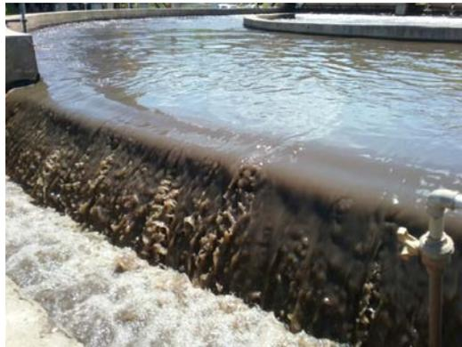
**Descrição(24):** Saída do reator lodos ativados com aeração orbal tipo carrossel
