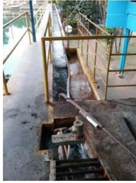
**Descrição(3):** Medidor de vazão ultrassônico e envio de dados à CCO e canal de direcionamento da água com o PAC para os floculadores
