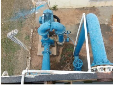
**Descrição(3):** Elevatória de recalque da água bruta para os 3 módulos de tratamento da água compactos
