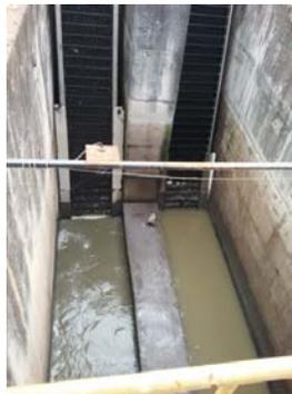
**Descrição(1):** Entrada de esgoto bruto com a comporta de gradeamento
