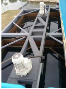
**Descrição(15):** Dois floculadores com agitadores mecanizados por módulo de tratamento
