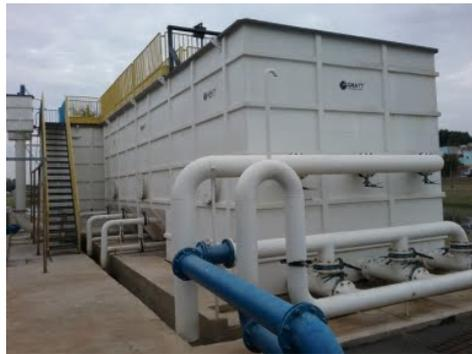
**Descrição(8):** Outra vista de um dos módulos compactos, evidenciando os barriletes das tubulações com registros e válvulas de manobras das vazões de descarga de fundo dos filtros rápidos de areia e decantadores para a limpeza dos mesmos
