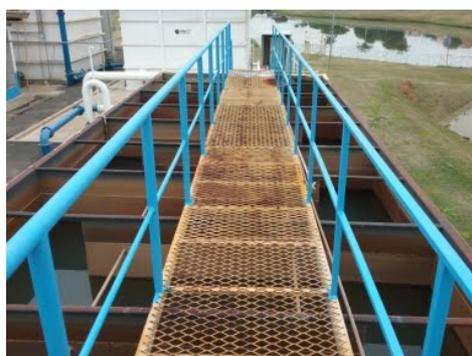
**Descrição(2):** Módulo de entrada da água bruta que distribui e alimenta os 3 Módulos metálicos compactos de tratamento da ETA V (capacidade de tratamento de 50 l/s em cada módulo)
