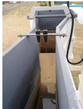
**Descrição(14):** Calha Parshall de um dos módulos de tratamento e medição da vazão da água bruta de entrada com ultrassônico
