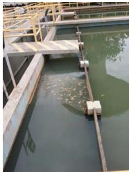
**Descrição(9):** Detalhe do canal de distribuição da água floclada em um dos decantadores
