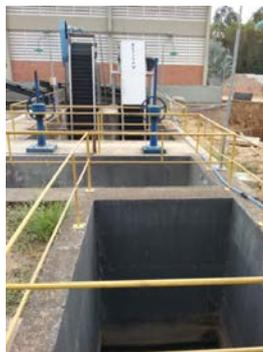
**Descrição(2):** Entrada de esgoto bruto com desarenador, e grade mecanizadas antes da EEEB que recalca para os módulos de tratamento de esgoto por sistema de lodos Ativados e areação prolongada no mesmo local
