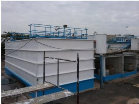
**Descrição(5):** Vista de um dos módulos de tratamento metálico compacto que tem a capacidade de 50 l/s
