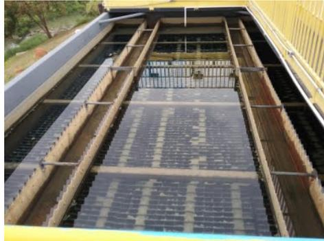
**Descrição(16):** Um decantador com colméia de preenchimento, fluxo ascendente por módulo de tratamento
