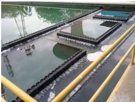
**Descrição(10):** Calhas dos vertedores da água decantada que na sequência é conduzida à série de filtros de areia
