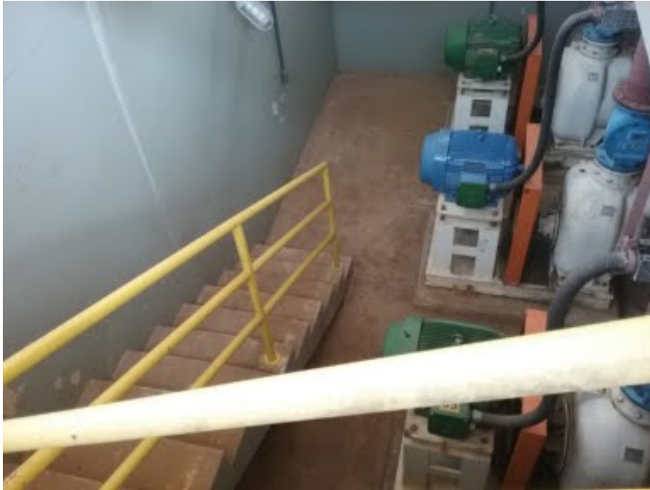
Descrição(6): Escada de acesso a casa de bombas com corrimão e guarda-corpos de proteção
