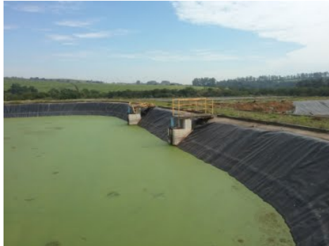
Descrição(8): Vista do 2º Conjunto de Lagoas Anaeróbia e Facultativa
