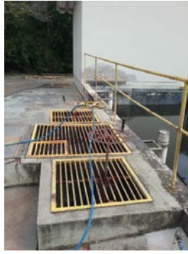
Descrição(15): Caixa de inspeção e registros de manobras das operações junto ao Decantador Imagem(16)
