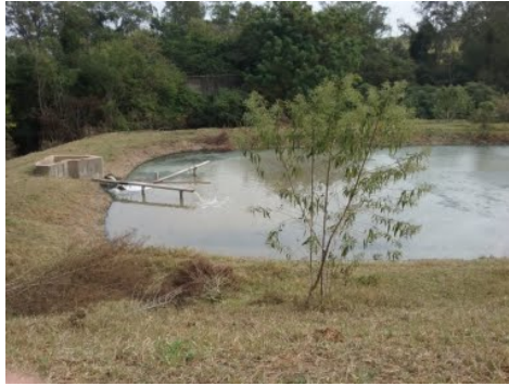
Descrição(7): Vista do Vertedor de entrada de uma Lagoa Facultativa na sequência da Lagoa Anaeróbia Imagem(8)
